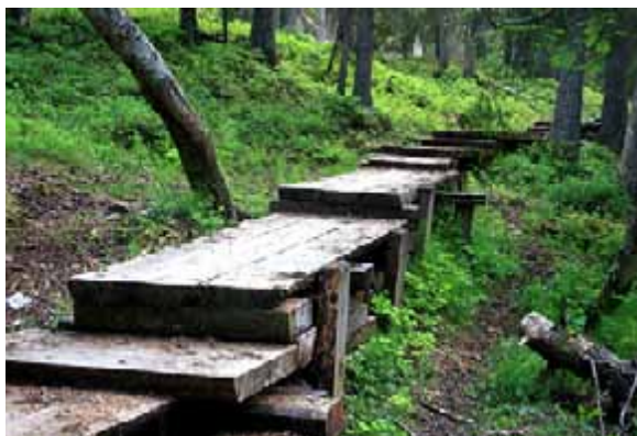
Varkaankurussa pitkostus uusitaan Ylläksen ympäristötyöhankkeessa vuonna 2011. Pitkosten muuttaminen pysyväksi murskepoluksi aloitettiin hankkeessa vuonna 2010. Kuvat: Maarit Kyöstiä.
