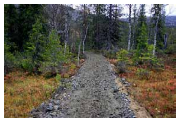
Varkaankurussa pitkostus uusitaan Ylläksen ympäristötyöhankkeessa vuonna 2011. Pitkosten muuttaminen pysyväksi murskepoluksi aloitettiin hankkeessa vuonna 2010. Kuvat: Maarit Kyöstiä.
