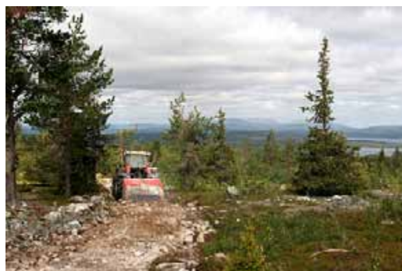
Muonion Särkitunturilla on kokeiltu paikallisen kiviaineksen murskausta suoraan polulle hyvin tuloksin. Kuvat: Pekka Sulkava.
