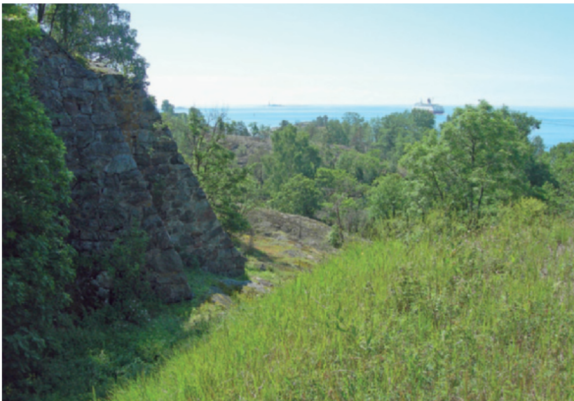
Kuva 2. Vallisaaren patterin VI länsipään linnoitusrakenteita ja näkymä etelään. Hiekkavallien päällä niittykasvillisuutta. Kuva: Katja Raatikainen.
