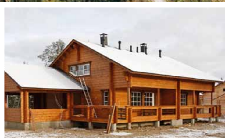
Valmista lomamökkiä haluaville ei Syötteen seudulla ole riittänyt tarjontaa ostettavaksi asti. Väänänsille löytyi kuitenkin mieluinen unelmatontti, jolle he rakennuttivat uuden vapaa-ajan asunnon.
