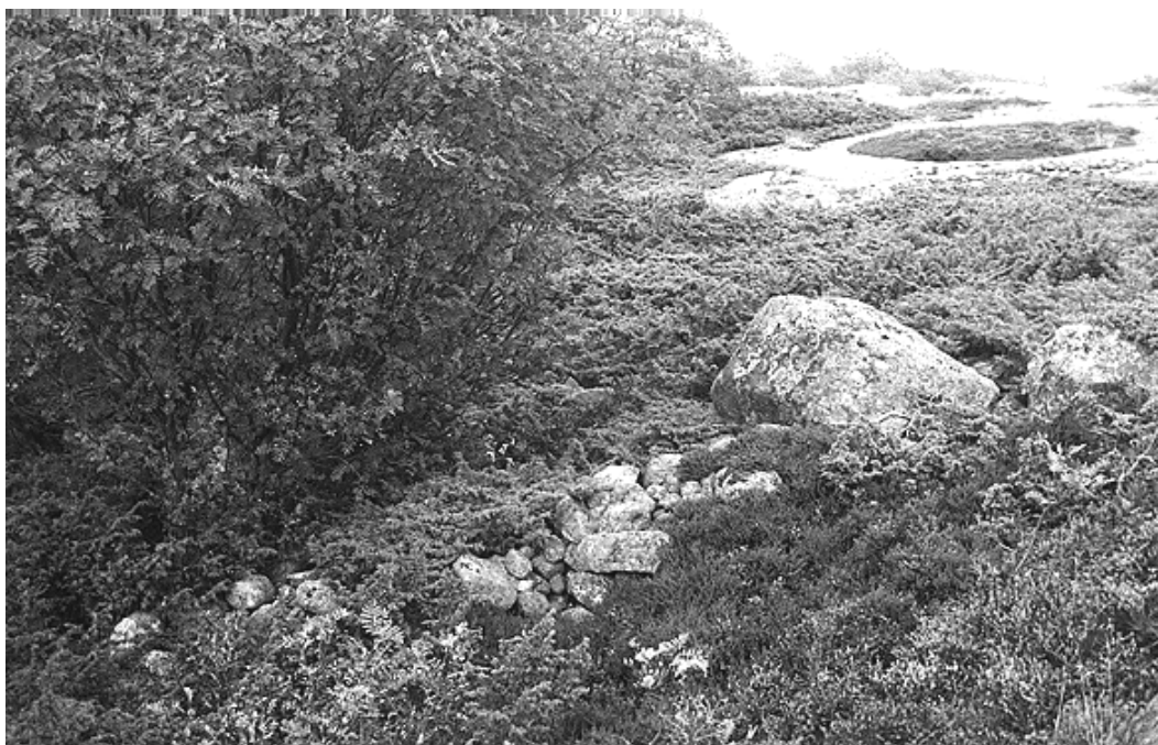
Kuva 25. Stenhuset. Kuorimuuuri on rakennettu jyrkkään pohjoisrinteeseen. Tapani Tuovinen 1995.
