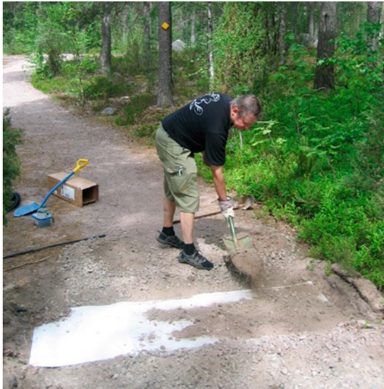
Painemattolaskurin asennus Nuuksion kansallispuistossa. Kuva: Teemu Kiviharju.
