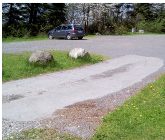
Esimerkki hyvin piilotetusta induktiivisesta sensorista: näkyvissä ovat vain kaapelioiden paikat. Kuva on Tanskan Store Dyrehavenista, jossa induktiivisia sensoreita on käytetty vuodesta 1977. Kuva: Frank S. Jensen.
