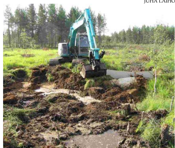
Kuva 11. Ilomantsin Juurikkasuolle tehtiin kesällä 2004 syvään ja leveään ojaan vanerilla tuetut padot, jotka kestävät veden paineen paremmin kuin pelkät turvepadot.
