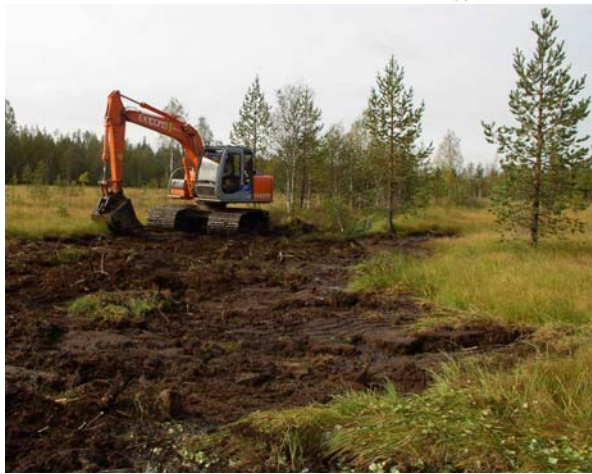
Kuva 10. Kaivinkone täyttää Rautavaaran Ristisuolla valtaojaa kesällä 2004.
