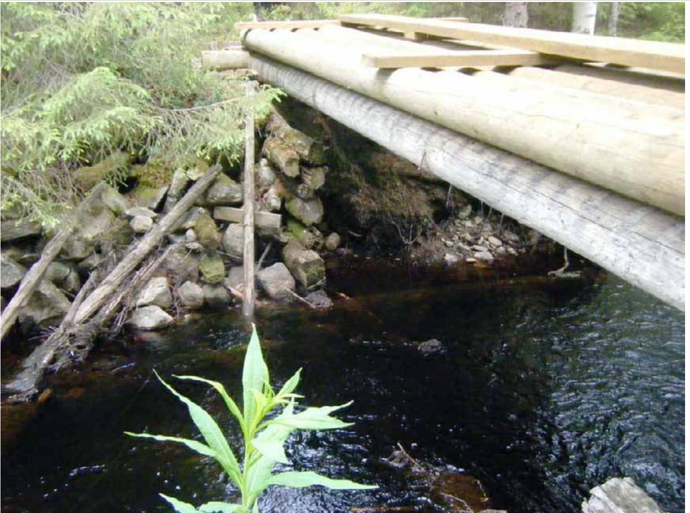
Uittopadon rakenteita polkusillan alla. Kuvaussuunta luode.
