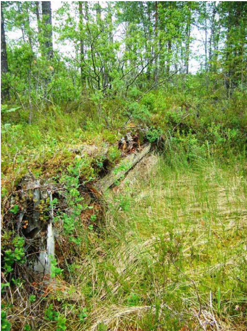
Rosvohodun padon rakenteita suolla.
