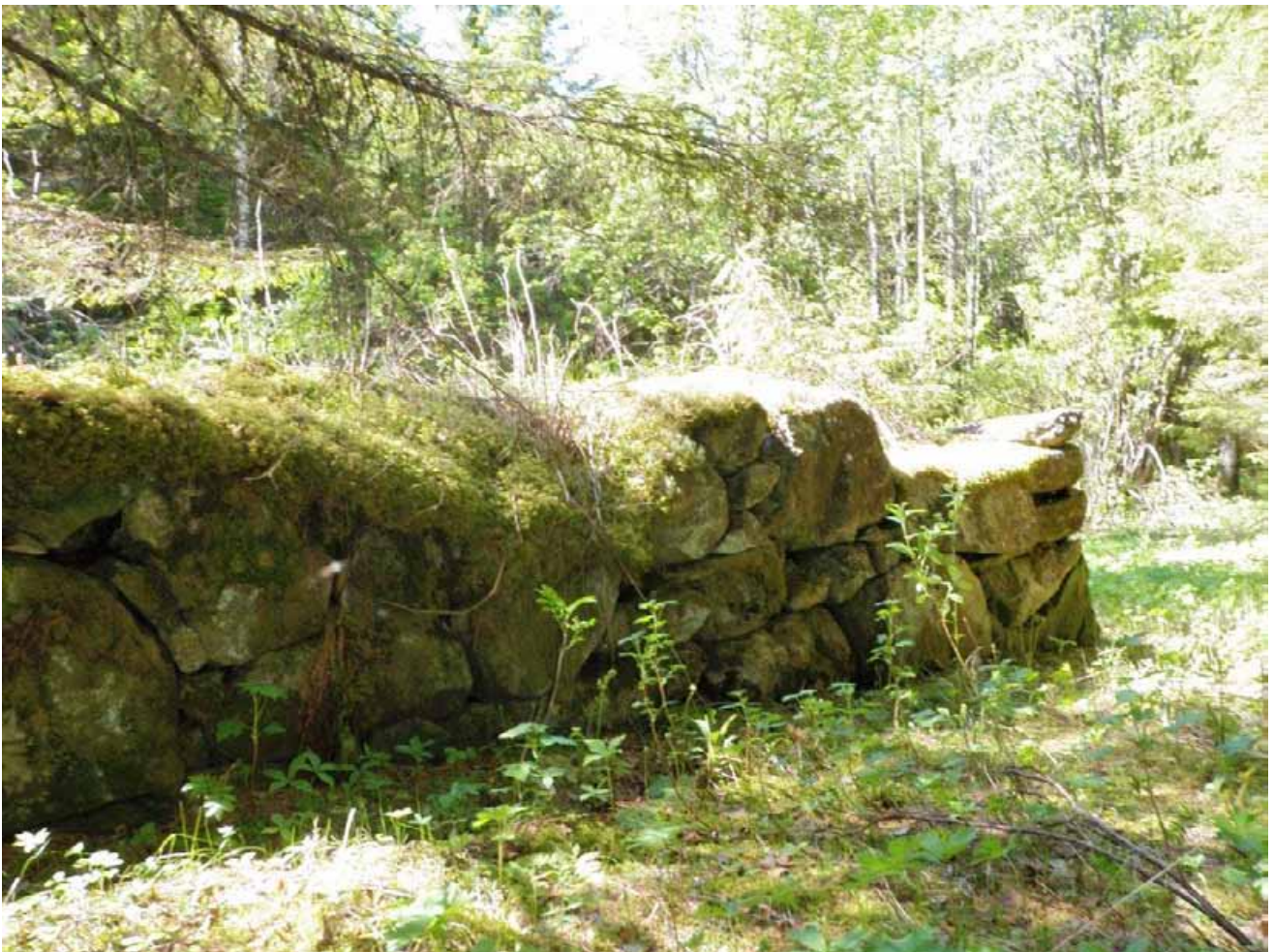
Lantalan ladottua kiviseinää.
