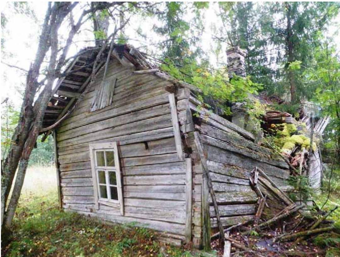
Kujanginlehdon päärakennus kuvattuna pohjoisesta.
