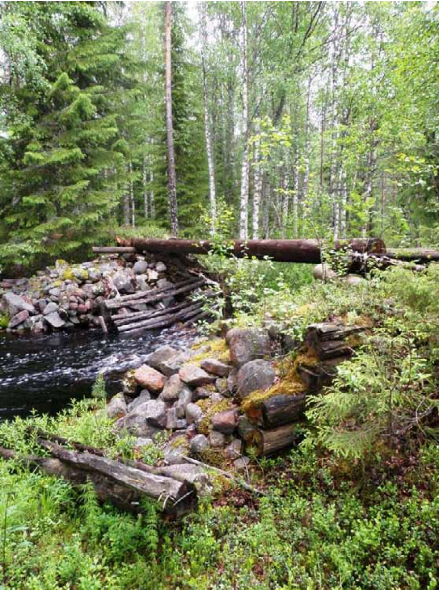
Uittopadon portin rakenteita ja yli kulkevat hirret.
