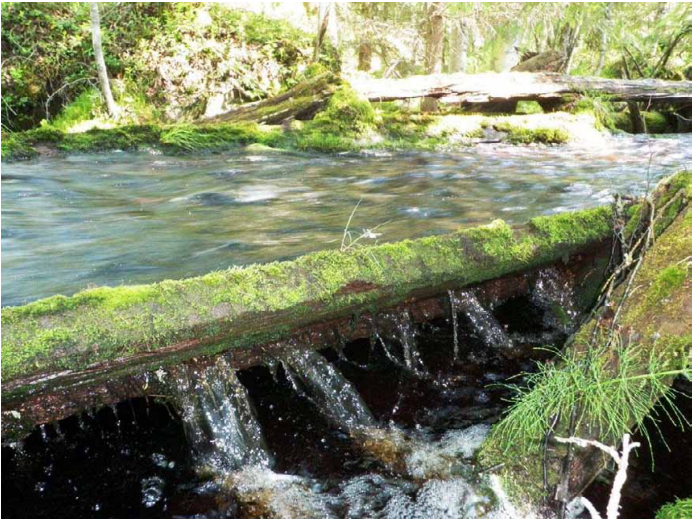
Puron päällä kulkeva lahonnut ja sammaloitunut uittoränni
