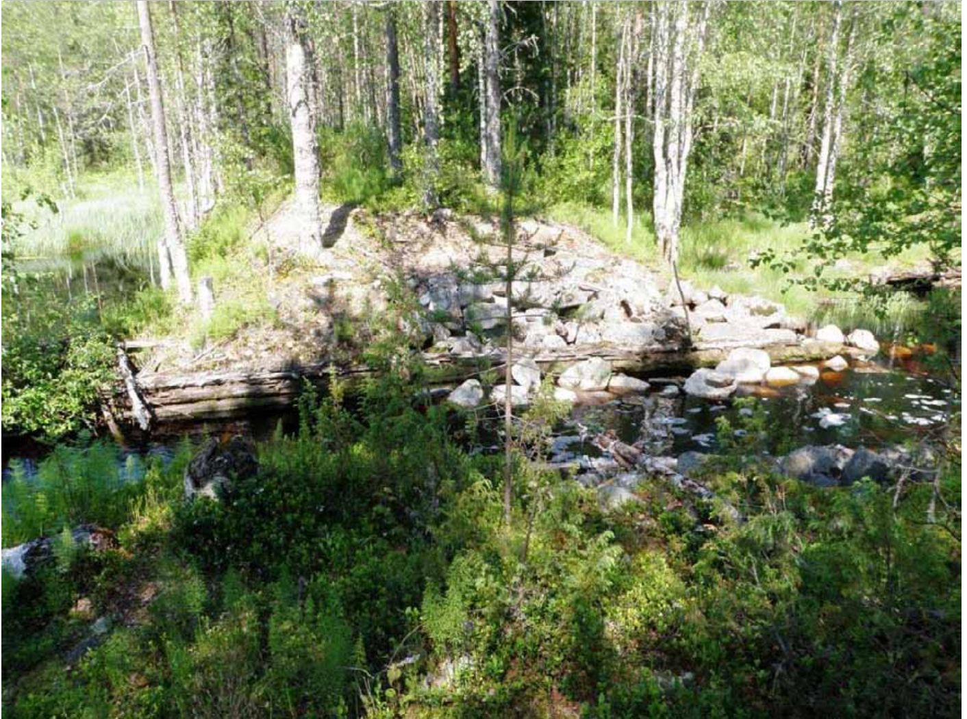
Uittopadon portin rakenteita.
