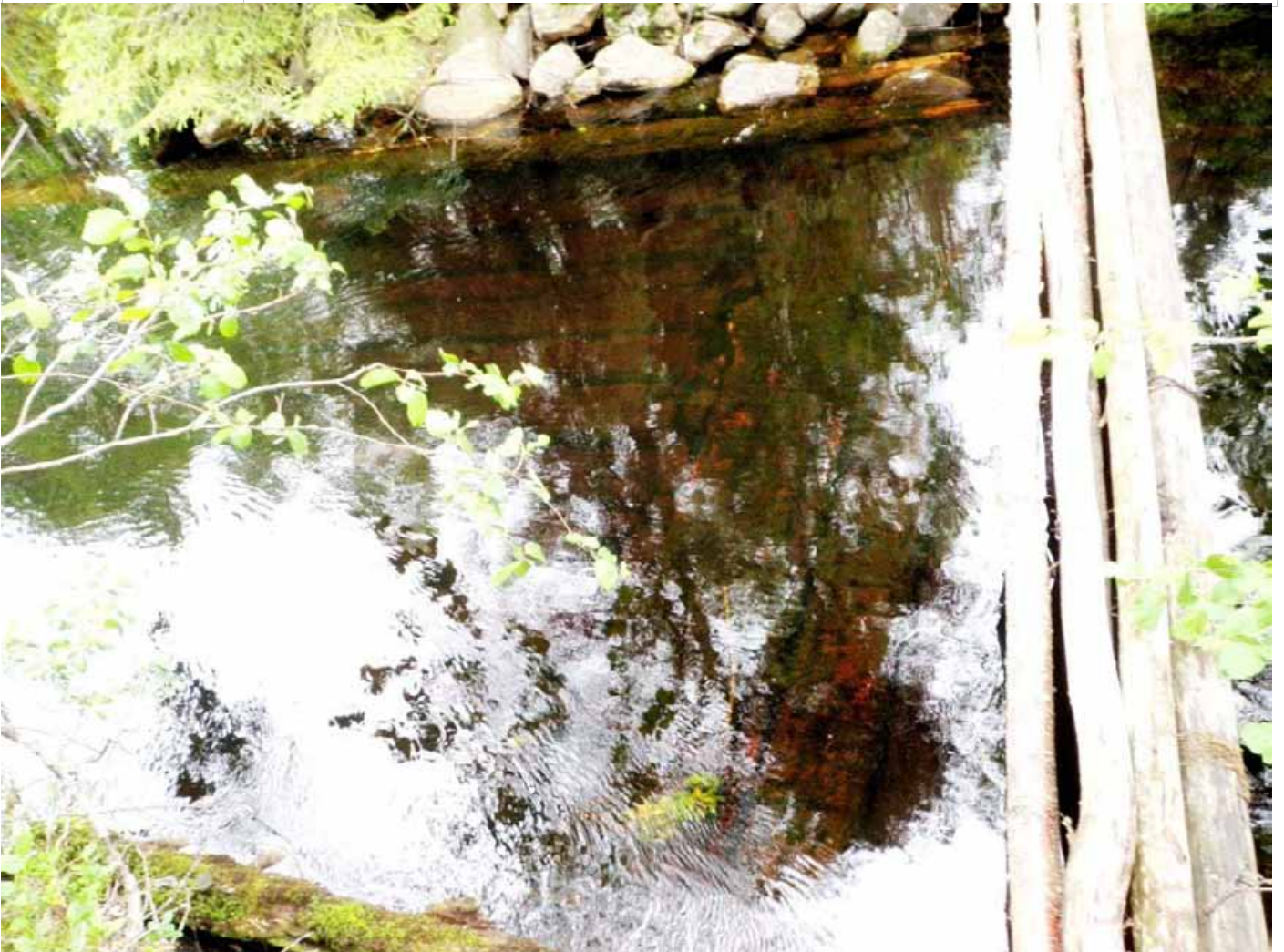
Uittopadon portin vedenalaista hirsirakennetta.
