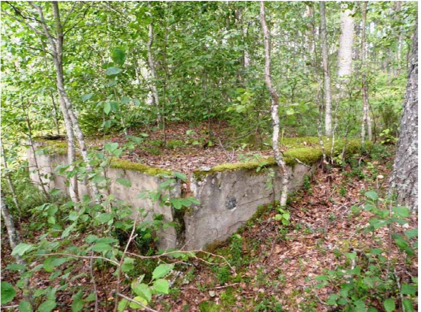
Betonista valettu saunan pohja.
