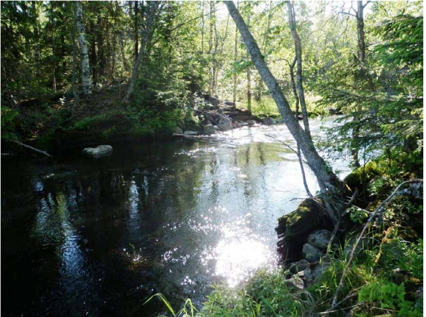
Uittopadon portin kivirakenteita näkyy vastarannalla. Kuvaussuunta länsi.
