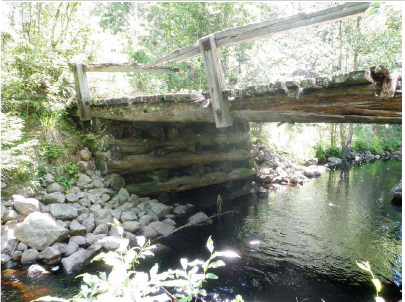
Lahonnut maantiesilta arkkuiheen.
