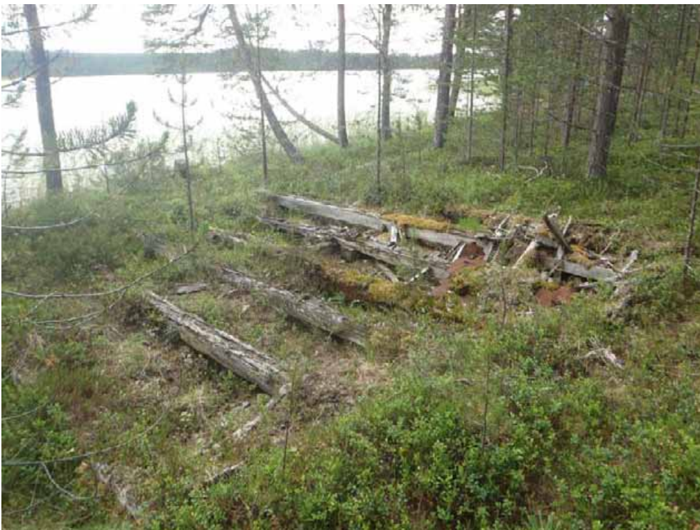
Pienemmästä rakennuksesta on jäljellä alimpia hirsikerroksia sekä metallia. Kuvan suunta etelään.
