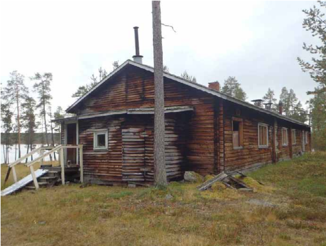
Pääkämpän itäpääty ja pohjoisseinä kuvattuna länsiluoteeseen.
