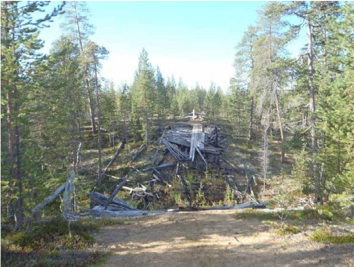
Romahtanut silta kuvattuna länteen.
