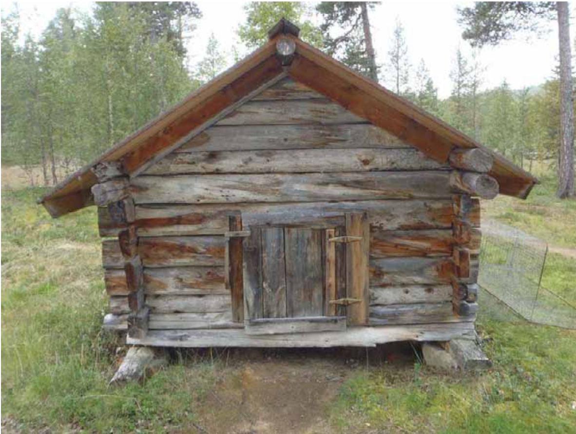
Aitan etuosa kuvattuna etelälounaaseen.
