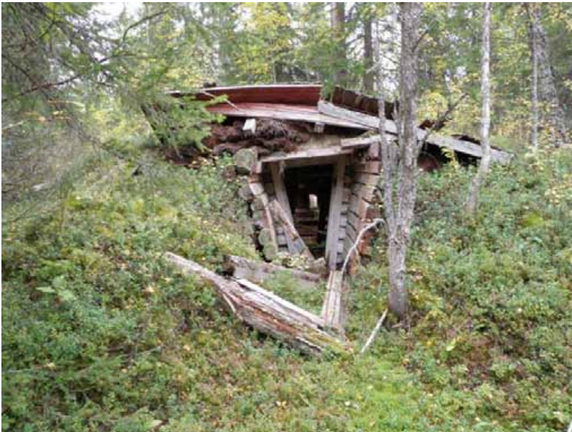
Kellarin ulko- ja sisärakenteita. Hirret on salvettu tiiviisti. Kuv. T. Karjalainen
