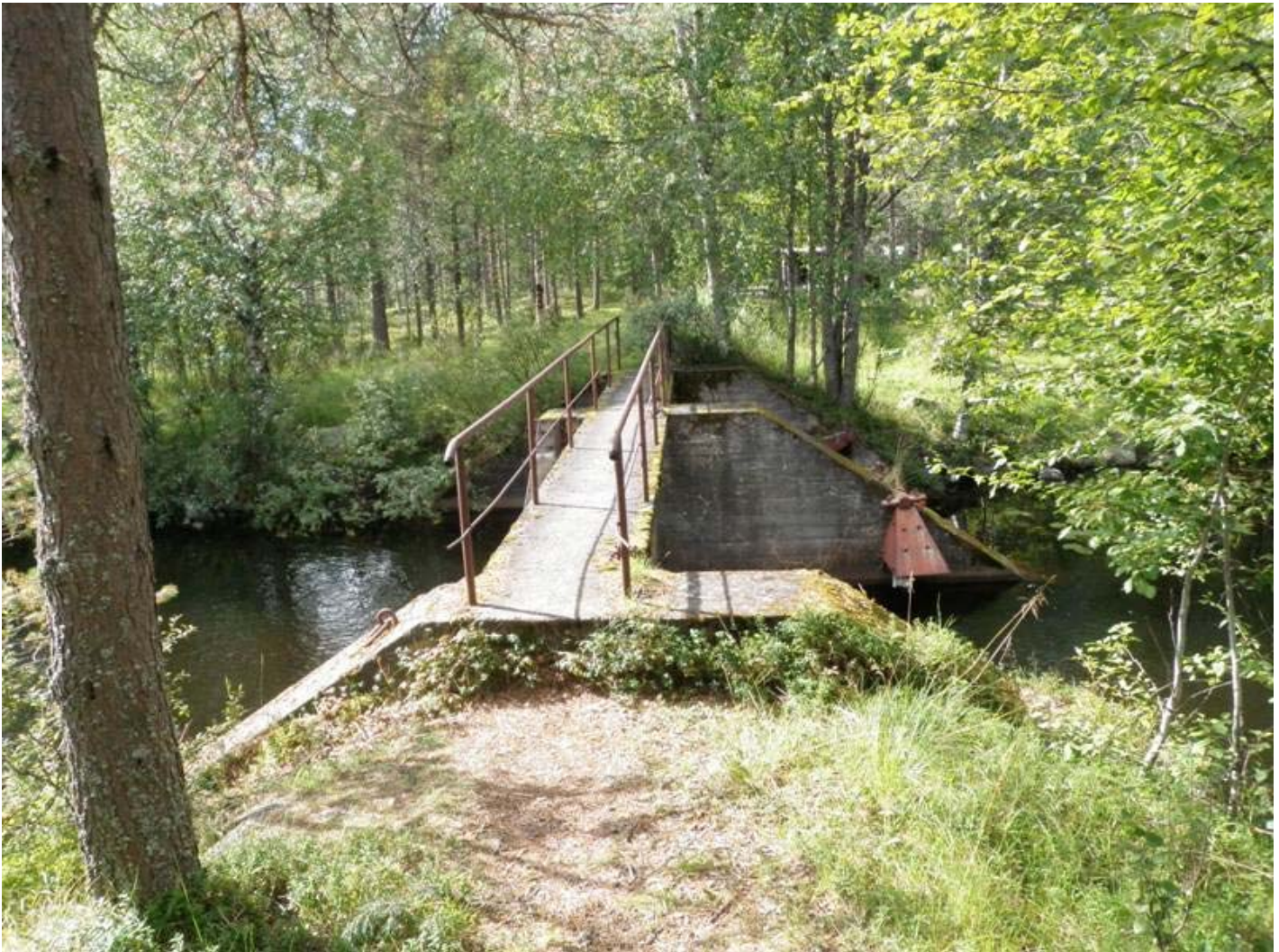
Uittopadon betoninen sillan kansi. Kuv. T. Karjalainen
