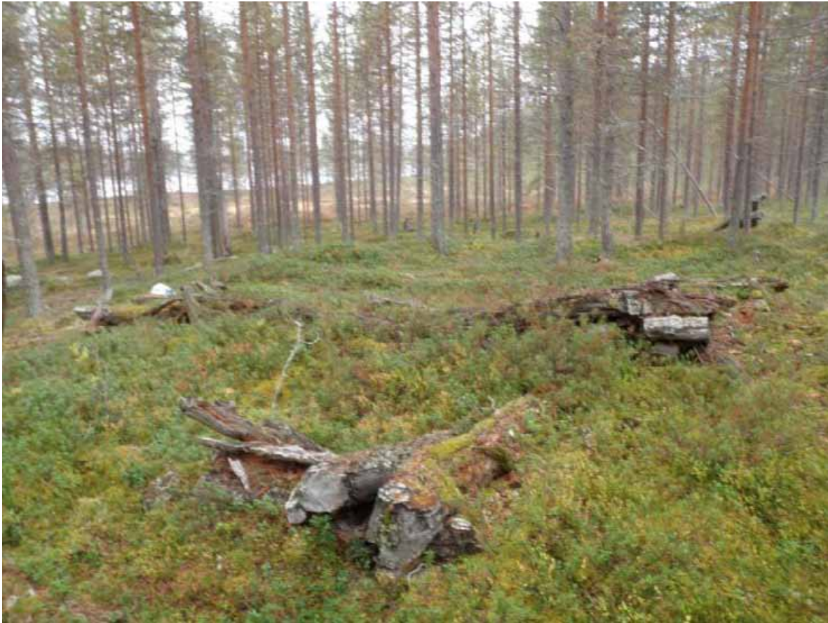
Hirret on katkottu sahalla ja nurkat salvettu molemmin puolin. Kuv. T. Karjalainen
