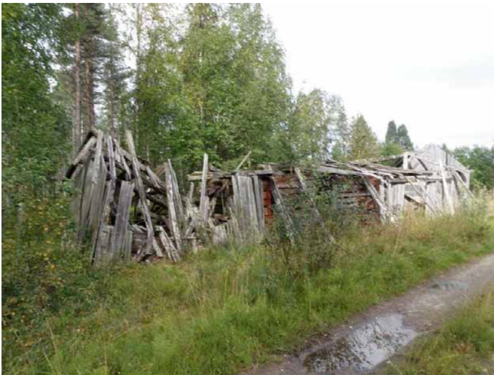
Navetta on tehty hirsistä ja molemmissa päissä on lautaiset heinäladot. Kuv. T. Karjalainen
