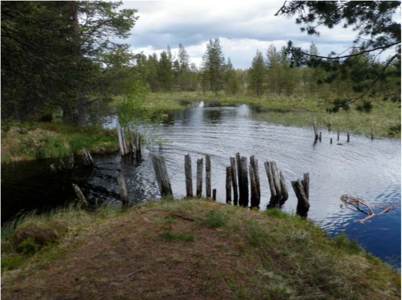
Uittopadon rakenteita on isketty ojan pohjaan. Kuv. T. Karjalainen
