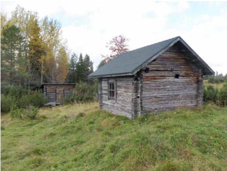
Konttilan tilan riihi ja ulkorakennus sijaitsevat järven rannassa. Kuv. T. Karjalainen
