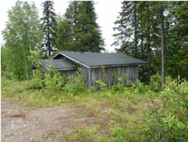
Taimikellari ulkoa ja sisältä. Katossa on tuuletusaukko. Kuv. T. Karjalainen
