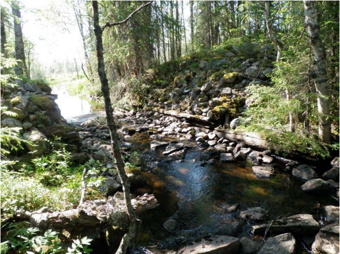
Uittopadon kivi- ja maavalli. Ojan pohjassa on puurakenteita. Kuv. T. Karjalainen
