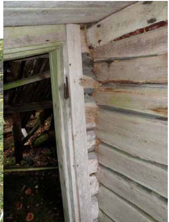
Kellarin ulko- ja sisärakenteita. Hirret on salvettu tiiviisti. Kuv. T. Karjalainen
