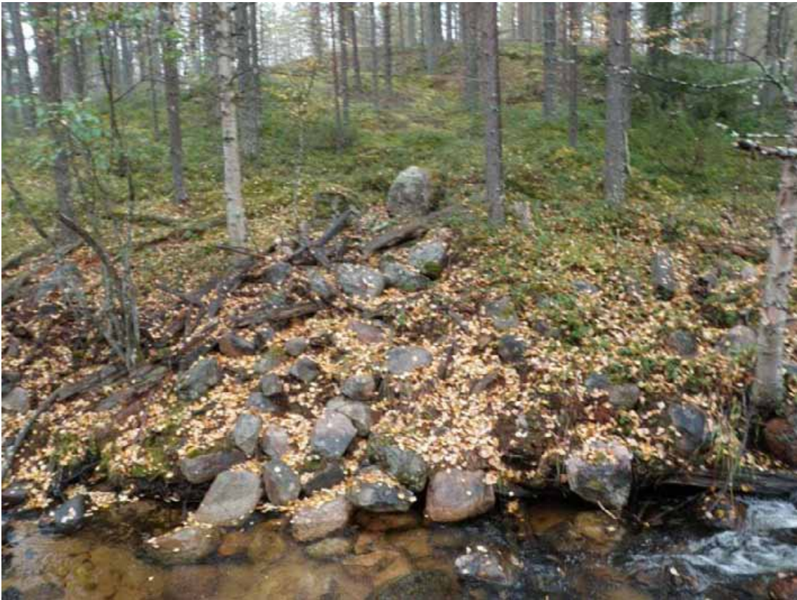
Uittopadon kivirakennetta ja lahonneita hirssiä. Kuv. T. Karjalainen
