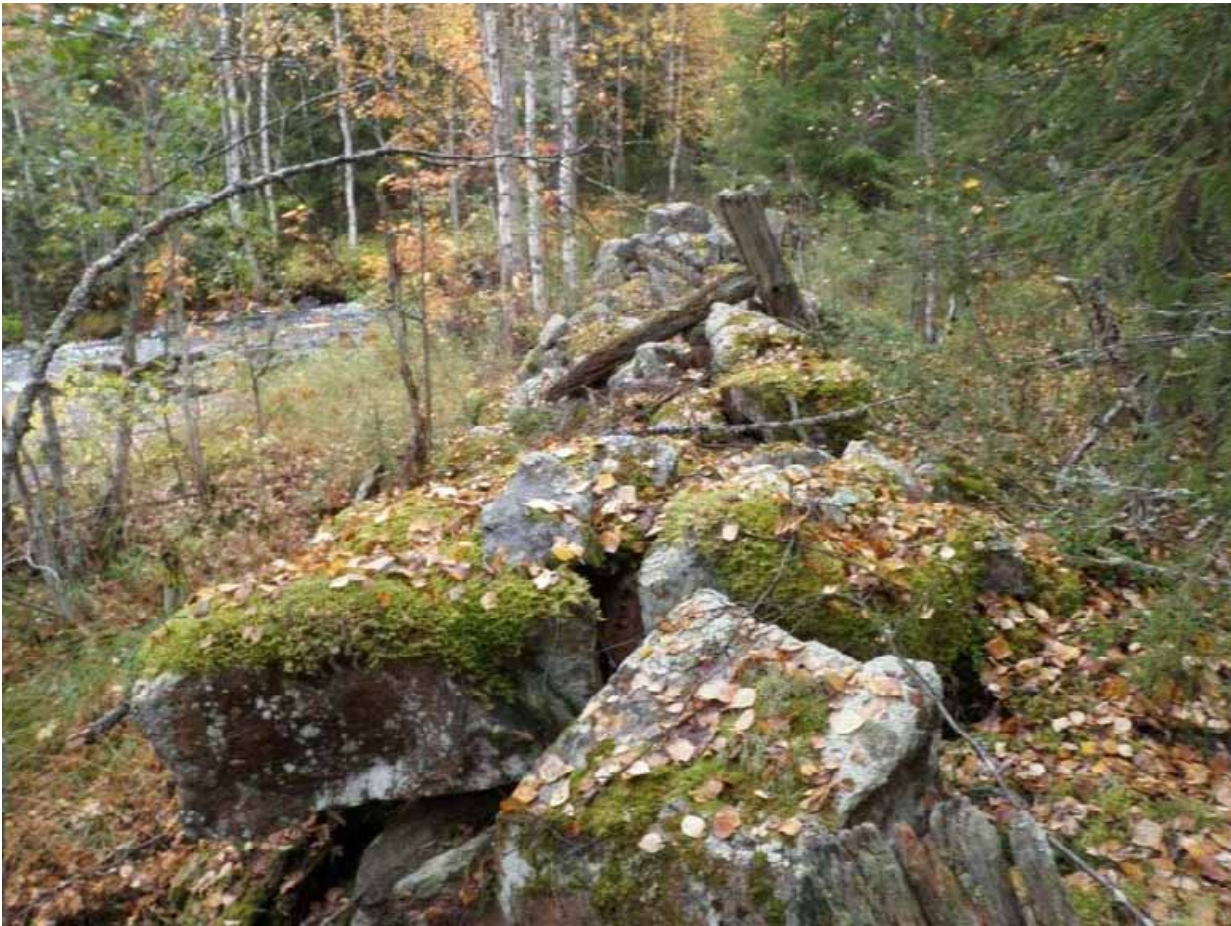
Uittorännin massiivisia kivrakenteita. Kuv. T. Karjalainen
