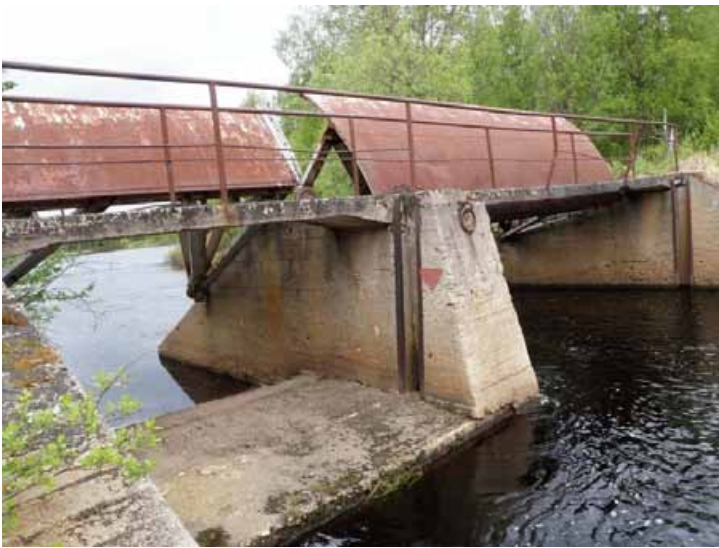
Uittopato ja luukkujen nostoon tarvittu vinssi. Kuv. T. Karjalainen
