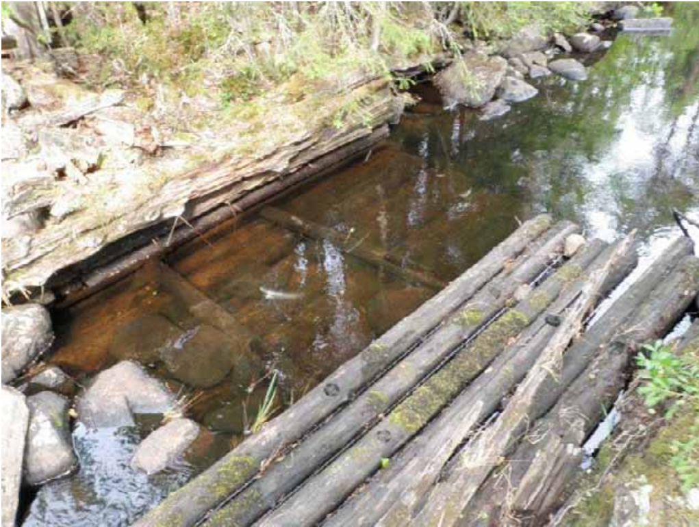
Uittopadon rakenteita ojan pohjassa. Kuv. T. Karjalainen
