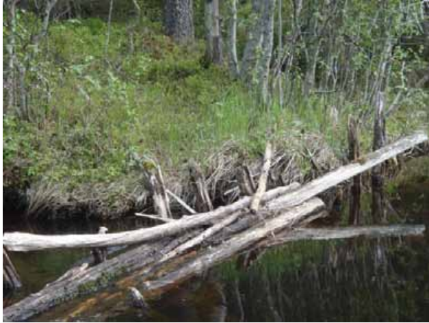
Yksityiskohtakuva padon pohjoispään rakenteista, etelästä.
