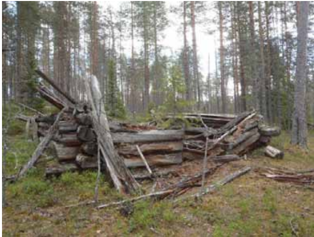
Rakennus 1, yleiskuva luoteesta.
