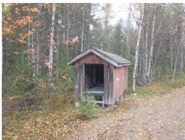
”Konehuone” kuvattu etelästä.
