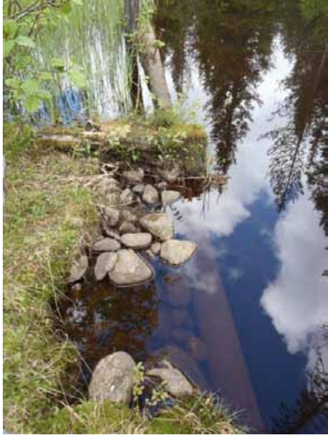
Sillan tukirakenteita kuvattu etelästä.
