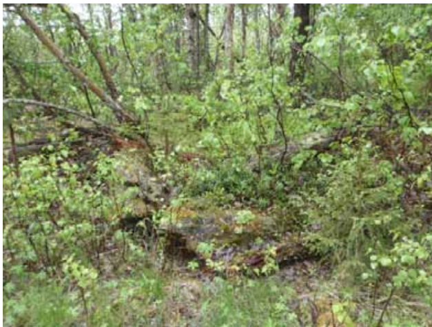
Rakennuksen nurkka kuvattu koillisesta.
