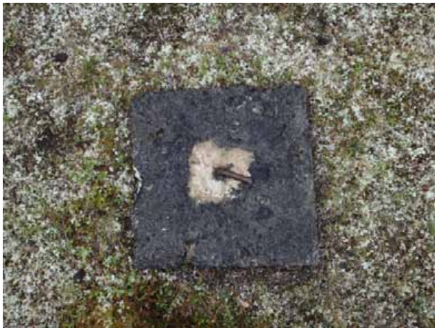
Lähikuva betonisesta tukirakenteesta.
