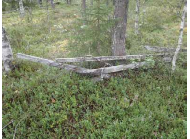
Johdinaidan jäänteitä koillisesta.
