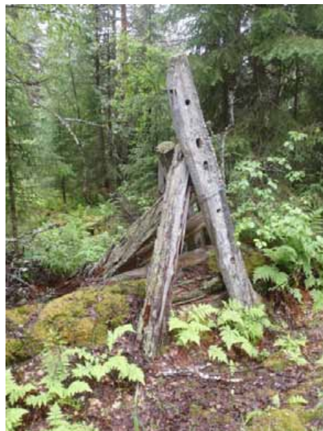
Rakennuksen2 pohjoispään teline lännestä.
