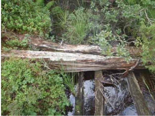
Yleiskuva rakenteista idästä.
