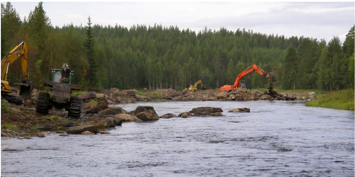
Perkauksen jälkeen kosken alle kulkeutunutta soraa ruopataan kutupaikkojen rakentamiseen, Kostonjoen Saarikoski. Kuva: Eero Moilanen.
