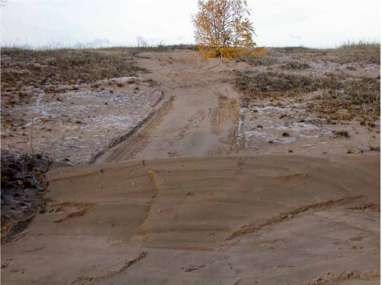
Kuva 5. Täytetty ajoura ja uran sulkemisesta kertova hiekkavalli liittymässä.
