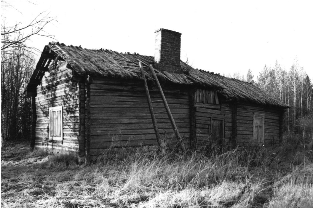
Kuva 9. Tiaisen päärakennuksen korjauksessa 1960-luvulla pirttipäädyn aiemmat neliruutuiset yhdenkertaiset ikkunat korvattiin kaksinkertaisilla, uudenaikaisemmilla ikkunoilla. Ikkuna-aukon koko suureni jonkin verran. Kuva: Päivi Tervonen / Kainuun Museo 1996.
