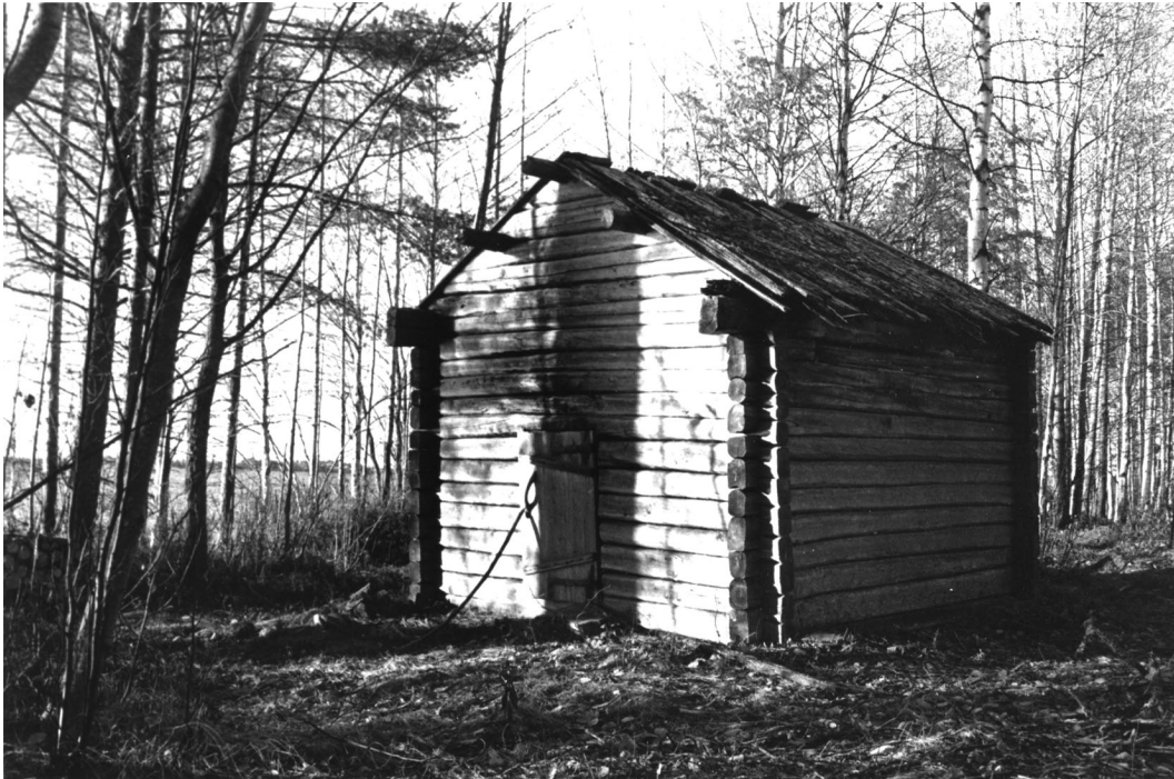
Kuva 11. Savusauna syksyllä 1996. Saunan alkuperäistä säröslautakattoa on korjattu mm. pirtin vanhoilla lattialaudoilla. Tiheän rantapuuston takaa näkyy Kalhamajärvi. Kuva: Päivi Tervonen / Kainuun Museo.
