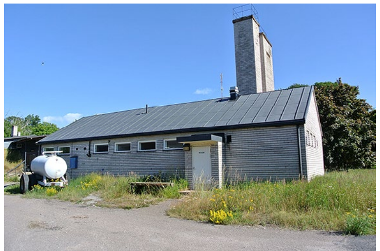
Oma lämpölaitos tuottaa tarvittavan kaukolämmön, ja keskeiset rakennukset ovat kaukolämmön piirissä. Öljylämmitys on tarkoitus korvata maalämmöllä. Kuva: Metsähallitus / Esko Sorakunnas.
