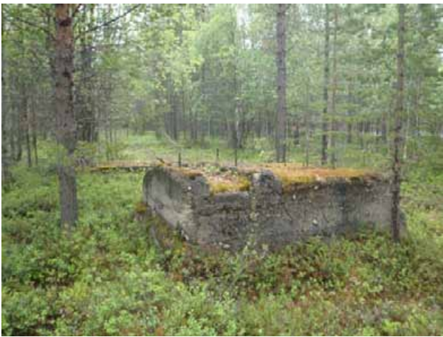
Betonivalut 1 kuvattuna itään.
