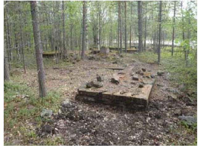
Rannassa sijaitsevan rakennuksen betoniperustusta kuvattuna kaakkoon.
