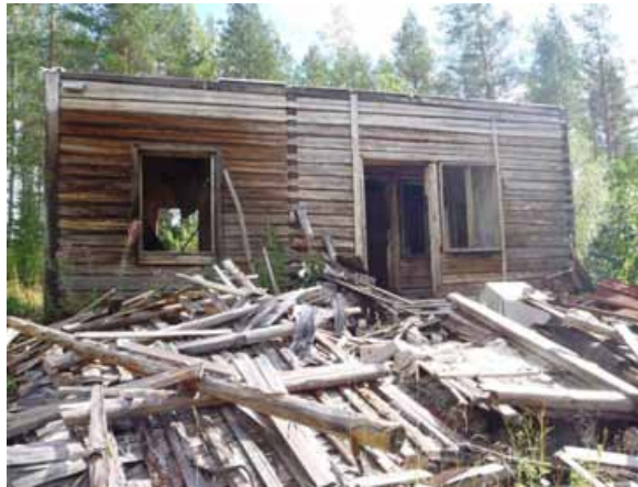
Päärakennus, kuvattu lännestä.
