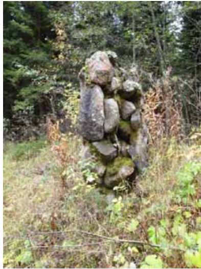
Kivi- ja betonirakenne, kuvattu lännestä.
