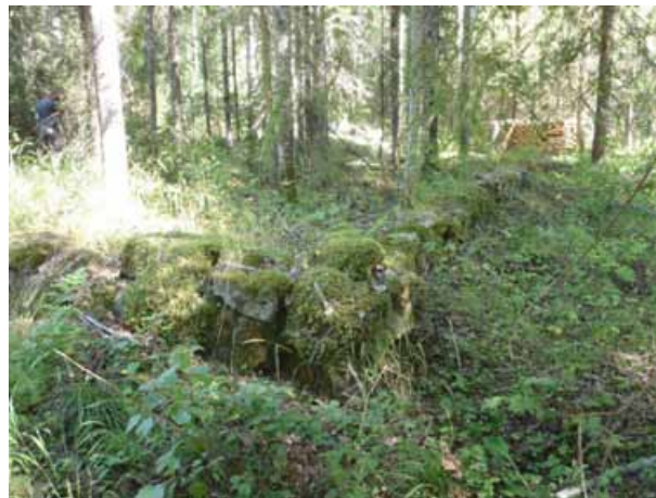
Rakennuksen 1 perustuksia, kuvattu lounaasta.
