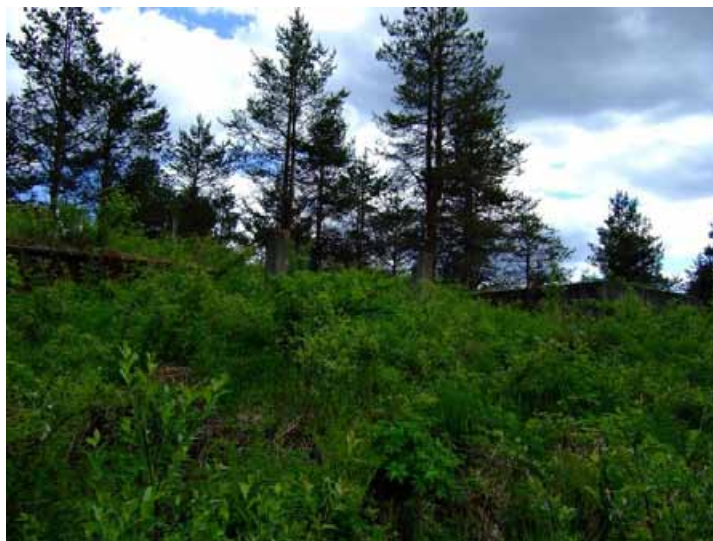
Rakennuksen 2 betoniperusta, kuvattu luoteesta.
