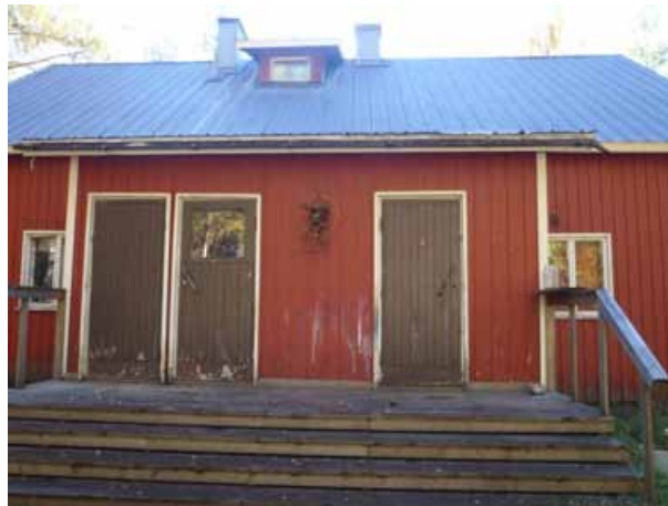
Päärakennus, kuvattu pohjoisesta.
