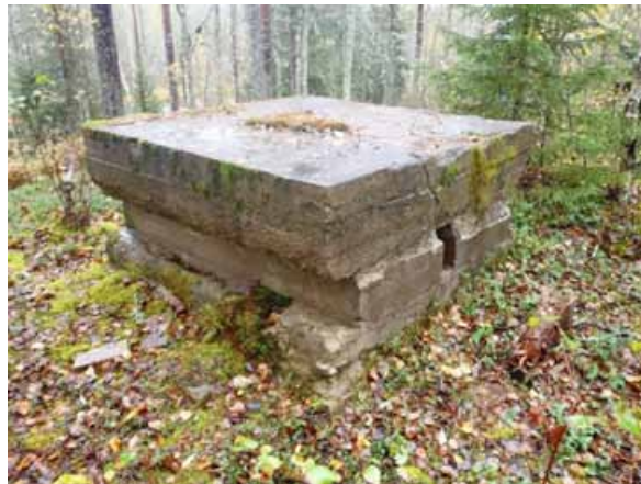
Betonirakenne, kuvattu luoteesta.
