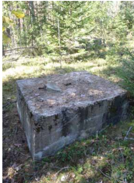
Tornin jalan pohja, kuvattu kaakosta.
