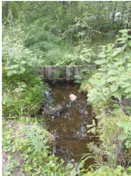
Pienen patorakennelman jäänteet ojassa, kuvattu pohjoisesta.
