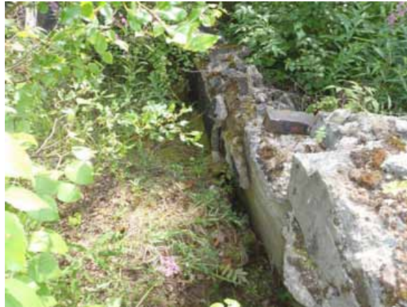
Rakennuksen betoniperustuksia, kuvattu lännestä.
