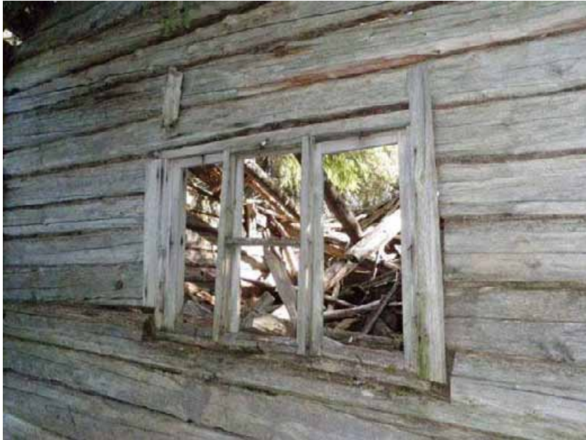
Lähikuva pohjoisseinän ikkunasta.
