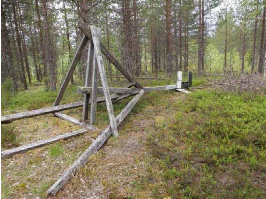
Kaadettu torni kuvattu koillisesta.
