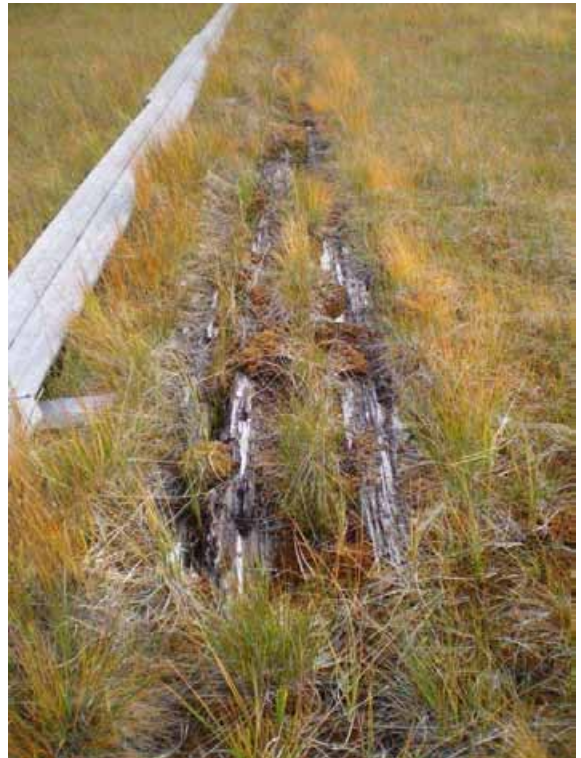
Lähikuva pohjoisesta (R.-V. Vaske)
