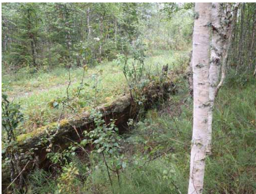
Padon tukirakenteet kuvattu lounaasta.
