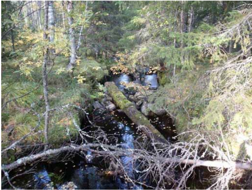
Kuva sillasta idästä.
