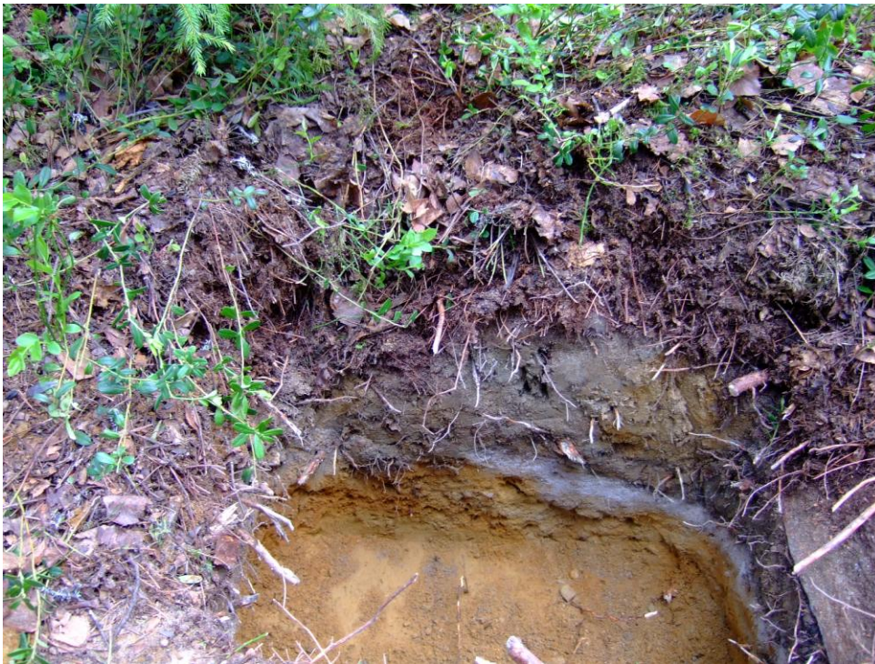
Kuva 9. Koekuopassa on näkyvissä täyttömaa vanhan turpeen päällä, kuvattu idästä.
