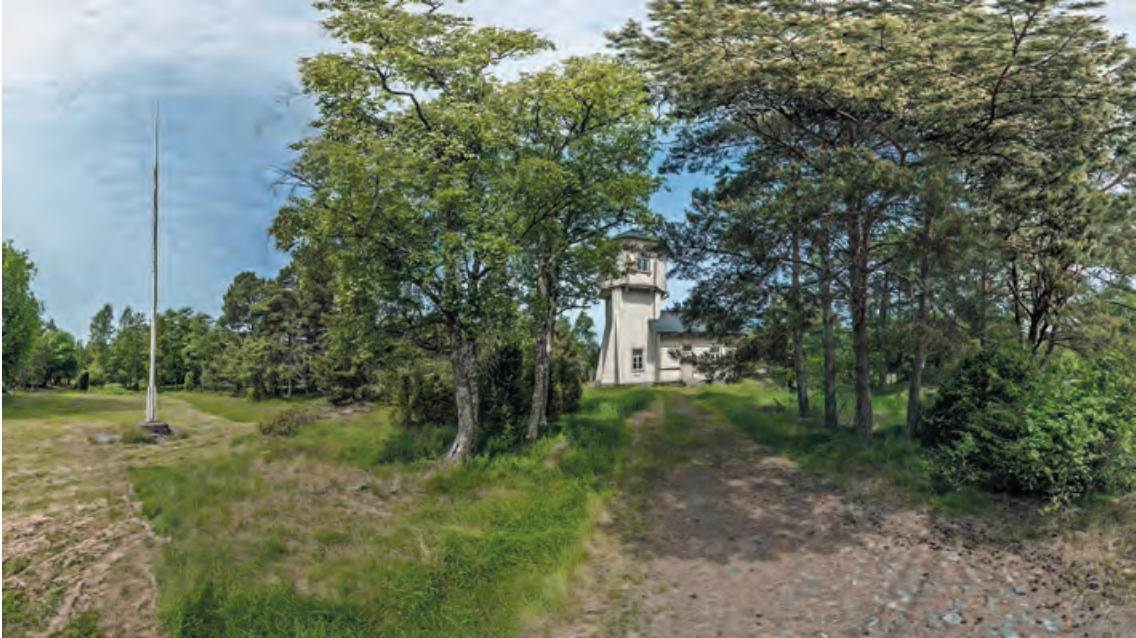
Kuva 6. Katanpään vesitorni on linnakkeen kulttuurihistoriallisesti arvokkain rakennus. Anssi Riihiaho / Metsähallitus
