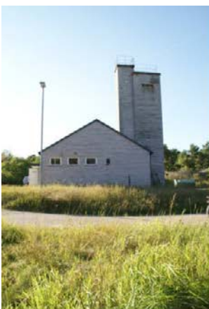
0068, lämpökeskus ja varusmies-sauna
