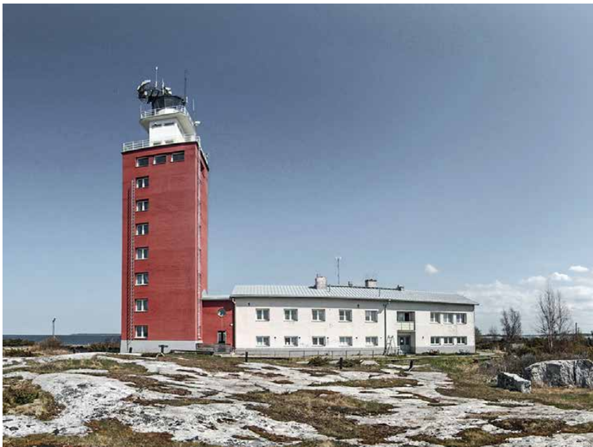
Kuva 84. Kylmäpihlajan majakka- ja luotsirakennus. Majakan tornin huoneet toimivat nykyisin hotellina ja rakennuksen matalammassa osassa on ravintola ja kappeli. Kuva: Metsähallitus/Anssi Riihiahho.
