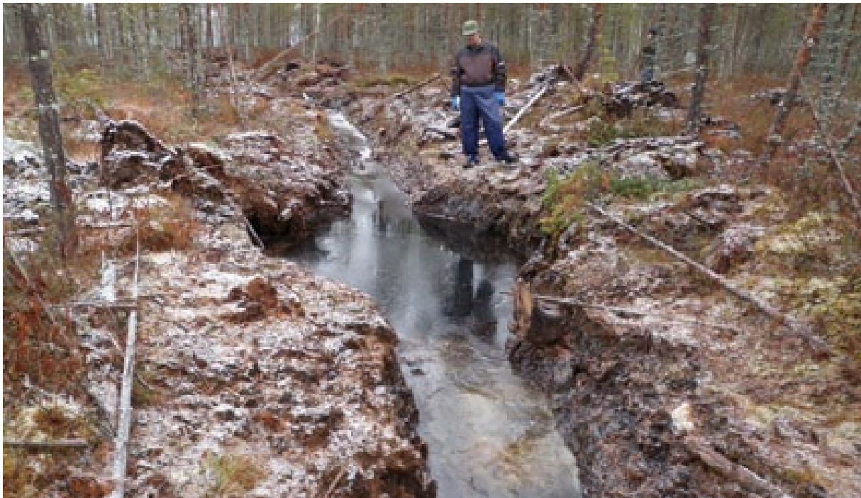
Kuva 4.1.9. Kunnostusojitusalueen sarkaojissa pidetään lietekuopilla veden mukana, ojan pohjaa pitkin kulkeutuvaa kiintoainesta. Kuva Ari Rautio.
