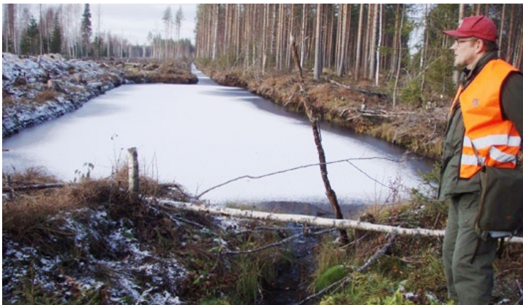
Kuva 4.5.6.4.a. Laskeutusallas pidättää ojastosta purkautuvasta vedestä kiintoainesta. Kuva Ari Rautio.
