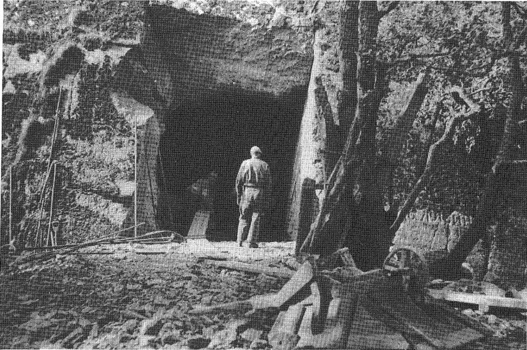
Linnoittamistöitä kiirehditään Huoltotunnelin suuaukko on puhkaistu Ulko-Tammiossa 5.8.1944. SA-kuva no 156563
