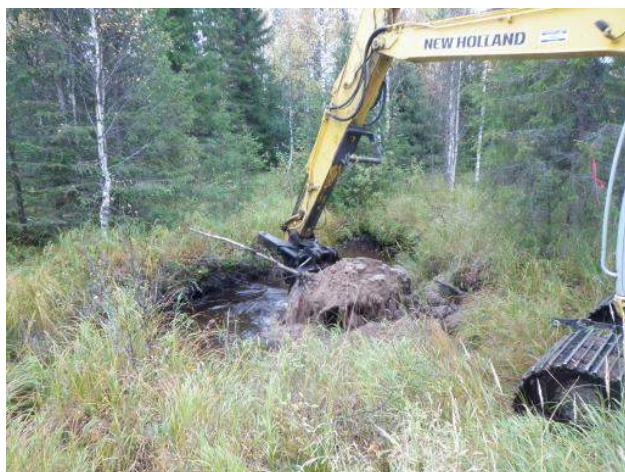
Kuva 10. Puroon kaivetun laskeutusaltaan tyhjennys kaivinkoneella
