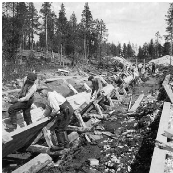
Siirtolaitoksen ruuhkan rakentamista. Lusto/Metsähallitus.
