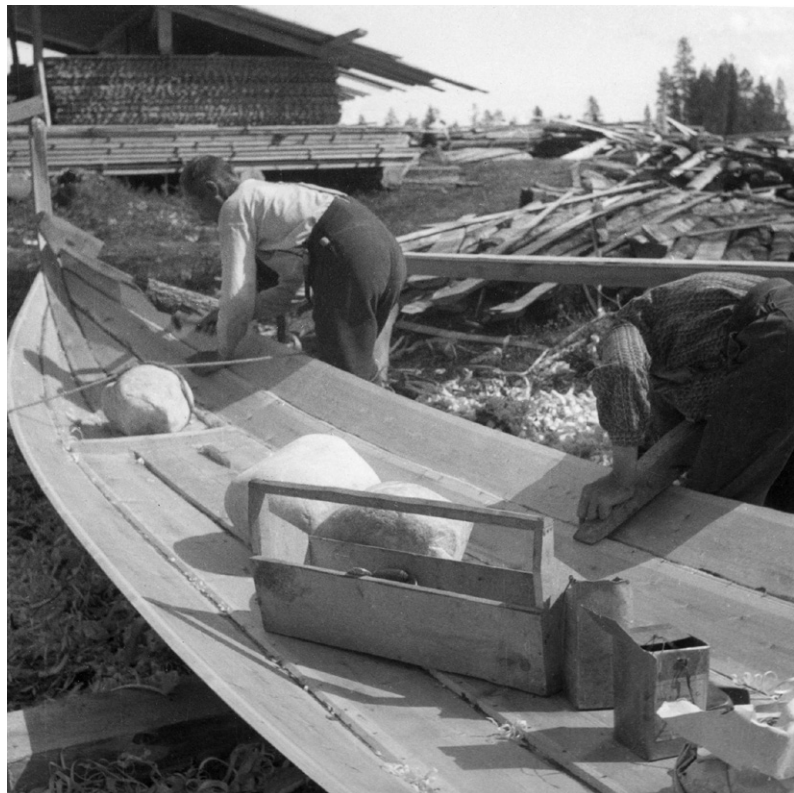
Veneiden tekoa uittoa varten. Kuva on Akanlahden kolmannen siirtolaitoksen työmaalta vuosilta 1935–1936. Lusto / Metsähallitus.
