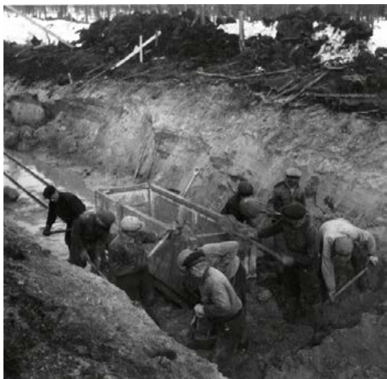
Ränniä varten täytyi varsinkin Kitkan ja Kuorikin välillä kaivaa paljon maata. PK.
