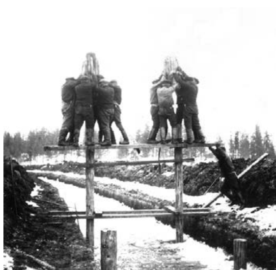
Miesporukka juntaamassa. Heidän työtään säästi lukkari lauluillaan, jotka varsinkin kokin lähestyessä muuttuivat ruokottomiksi 826 . PK.
