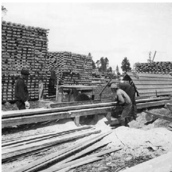
Siirtolaitosta varten tarvittiin paljon lankkuja, hirsii ja lautoja, jotka kaikki sahattiin paikan päällä. Lusto/Metsähallitus
