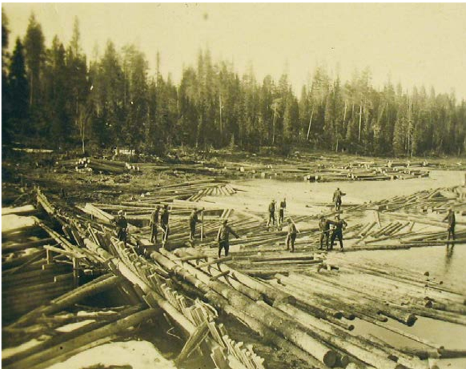
Uittoa Pudasjärven pohjoispuolella sijaitsevalla Kivarinjoella vuoden 1910 tienoilla. Työntekijät ohjaavat puita kaplastuksilta käsin kohti patoaukkoa. Kuvannut Aukusti Juurikka. OMA HRR.
