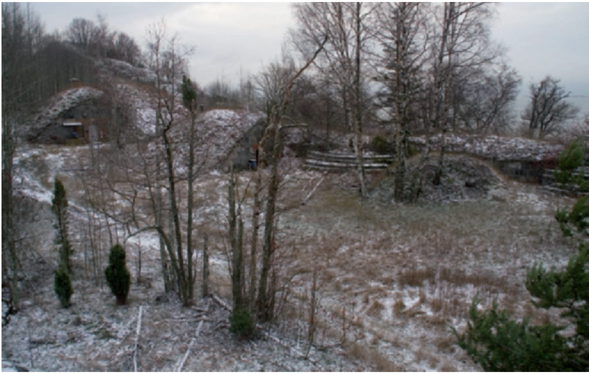
Kuva 27. Vallisaaren patteri II:n takapuoli. Kuvassa näkyvät korotetut kivistä tehdyt tykkiasemat. Kuva: Henrik Jansson.
