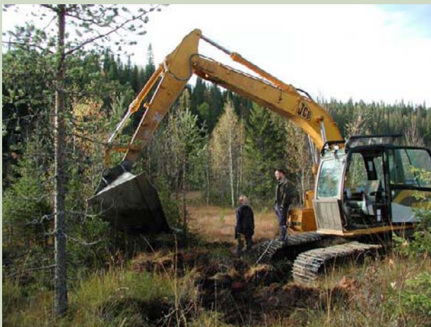
Suo-ojan tukkiminen tehdään nykyisin konevoimalla. Kuva: Metsähallitus.
