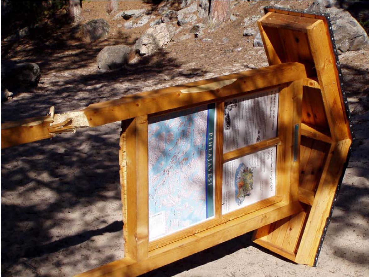
Rikottu opastetaulu, Pihlajaveden Natura-alue. Reitit, rakenteet ja opasteet vaativat jatkuvaa seurantaa sekä ajoittaista korjausta ja huoltoa. Myös opasteiden sisällöt vaativat uusimista määräväleihin. Kuva: Pasi Ikonen.
