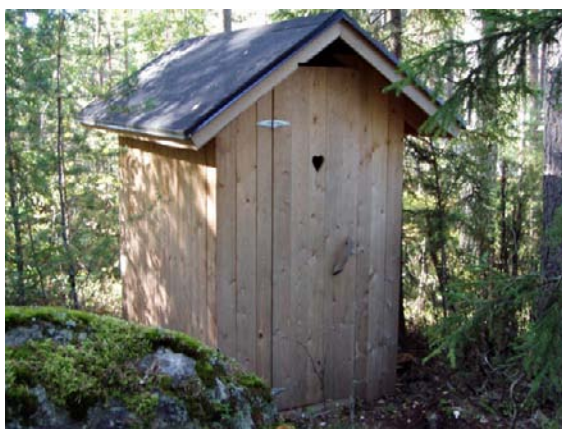
Kompostikäymälä Mustasaarella, Pihlajaveden Natura 2000 -alueella. Metsähallituksen luontopalvelut huoltaa suojele- ja retkeilyalueilla 1 600 kompostoivaa kuivakäymälää. Perinteistä menetelmää parannetaan jatkuvasti. Kuva: Pasi Ikonen.
