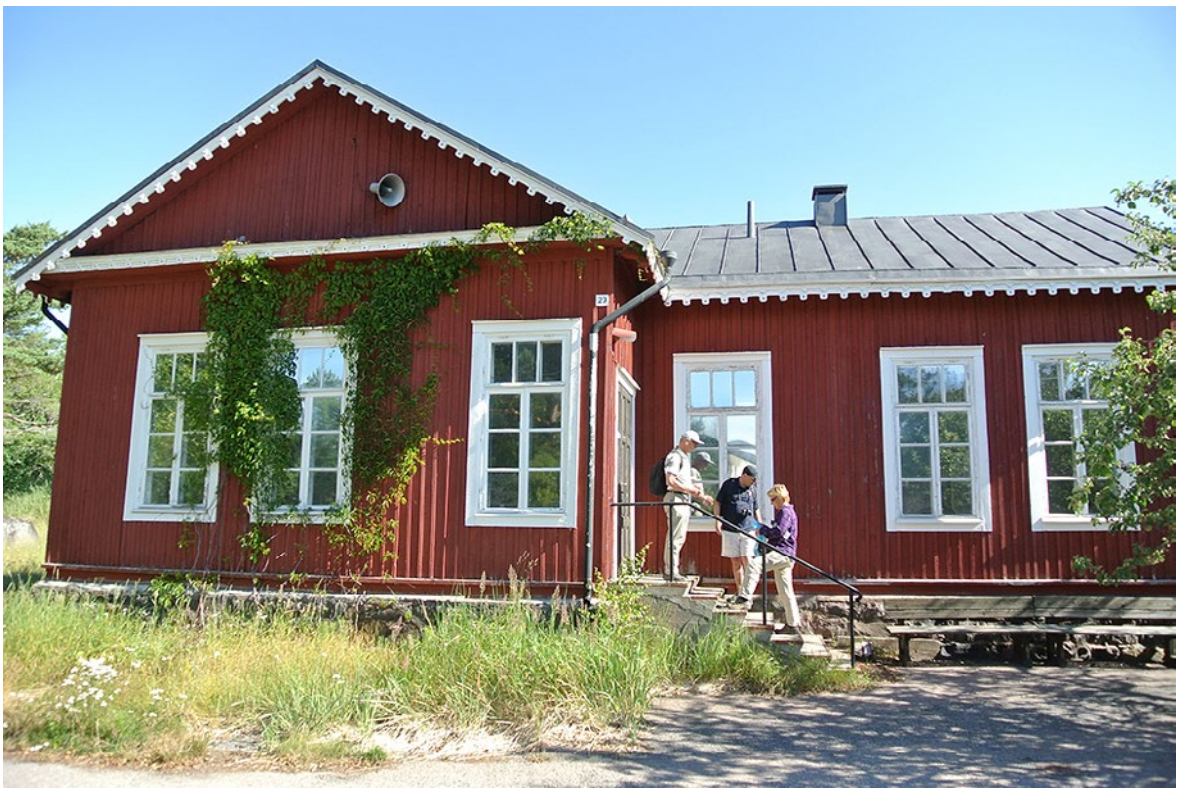
Örön suojeltavaa rakennuskantaa, vuonna 1916 rakennettu 12 n kasarmien toimisto, joka soveltuu hyvin kokous- ja koulutuskäyttöön. Sen neljä tilavaa huonetta on toimiva ratkaisu useiden samanaikaisten kokousten pitämiselle tai seminaarin ja ryhmätyötilojen vaatimuksille. Kuva: Metsähallitus / Esko Sorakunnas.
