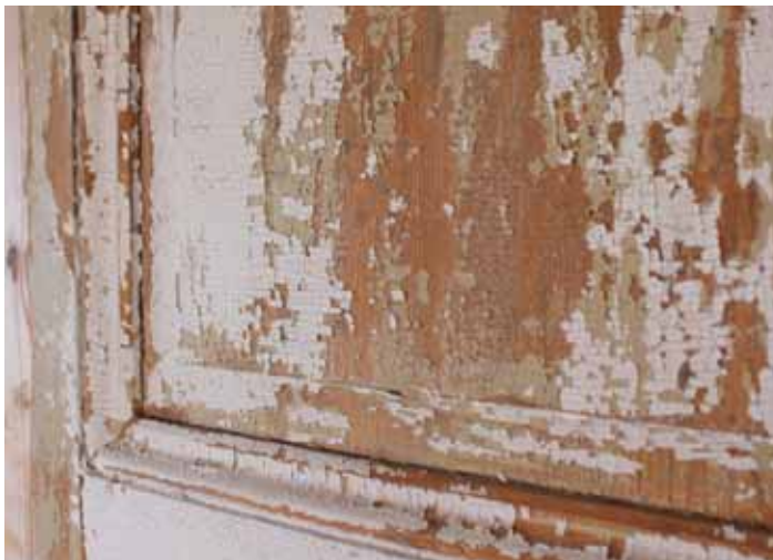
Åldrad krakelerad linoljafärg Vanheneva pellavaöljymaalii krakeloi
