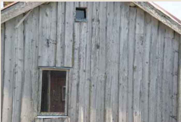
Västra fasaden / Läntinen julkisivu
