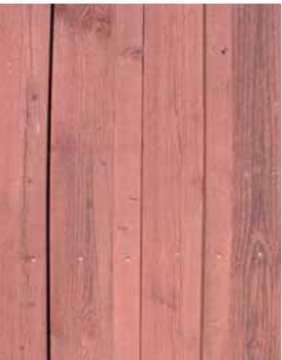
Rödmylla med sältran Punamulta hylkeentranilla
