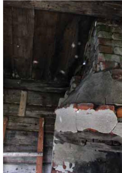
Stugans råspis, lägg märke till holvets träkonstruktion Tuvan nurkkatakka, huomaa puinen tulikaari
