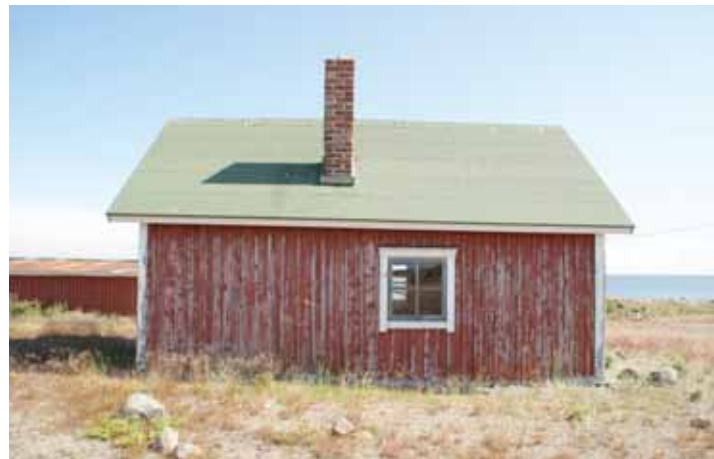
Fasad mot väster / Julkisivu länteen
