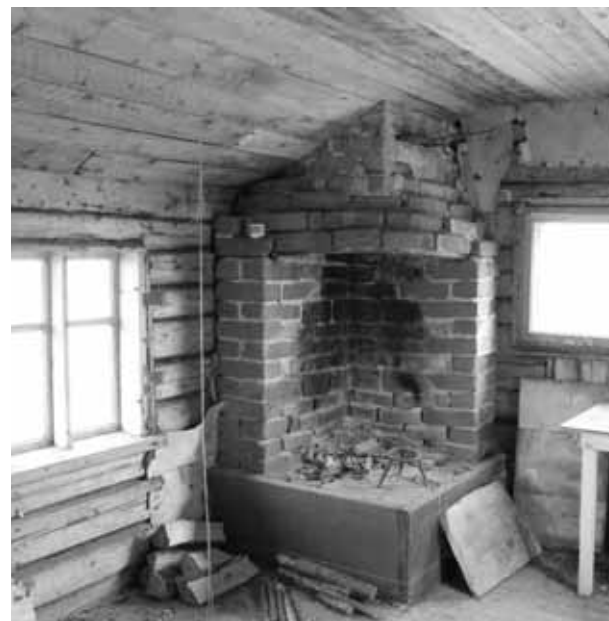
Exempel på fiskebastunas råspisar Esimerkkejä kämppien nurkkatakoista
