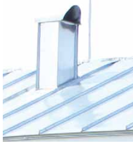
Nytt falsat plåttak Uusi saumattu peltikate
