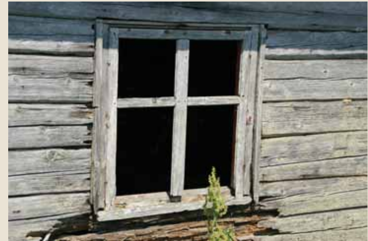
Södra fasadens fönster / Läntisen julkisivun ikkuna
