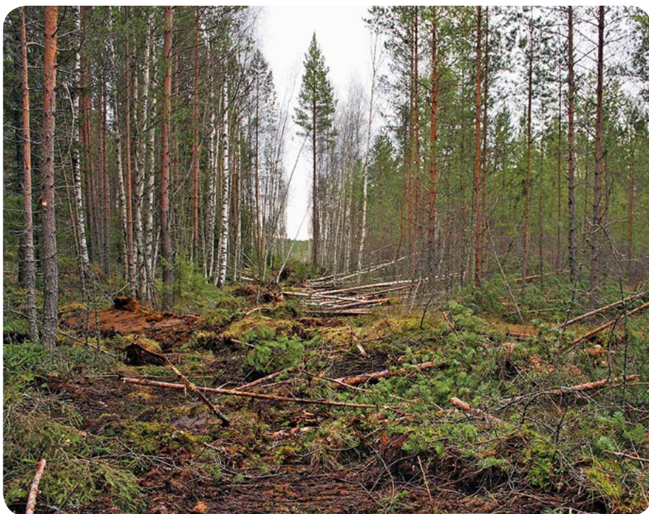
Diket fylls igen med hjälp av gamla dikesmarker och torv. BILD: JOUNI PENTTINEN
