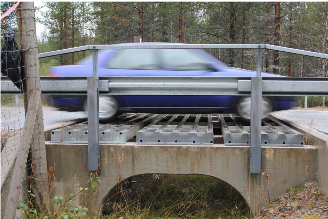
Rytisuon peuraestesillan uusi kansi. Kuva: Pekka Kilpeläinen.
