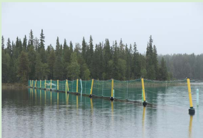
Suomussalmen Raatejärveen rakennettu kelluva aita on osa itärajan poroesteaitaa. Kuva: Milla Niemi.
