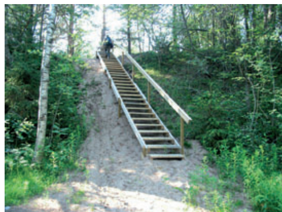
Kuva 54. Kommelipakan jyrkälle rinteelle tehdyt portaat. Irtonaisessa hiekassa portaiden vieressä näkyy jo valumista. Mikäli kulkijat eivät pysy portailla, paljas hiekkapinta kuluu nopeasti. Pirjo Hellemaa 2008.
