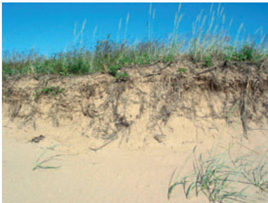
Kuva 48. Aallokon dyyniin kuluttama törmä maalialueen eteläpuolella. Pirjo Hellemaa 2008.
