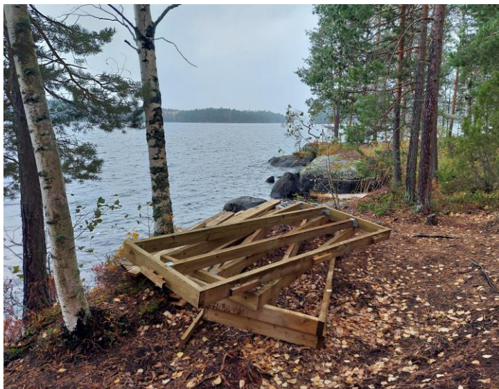
Kuva: Rakenteilla olevien teltta-alustojen pohjia Enonrannassa. Satu Tuomela.
