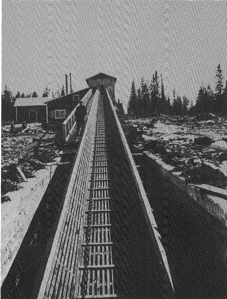
Kuva 32. Akanlahden tukinsiirtolaite Posiolla vuonna 1936. Siirtolaitteella nostettiin puut uittoränniin. Metsähallitus.
