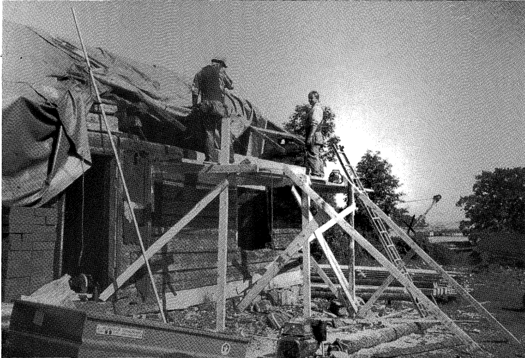
Kuva 9. Metsähallituksen kiinteistöpalveluiden rakennustyömaa Jussarössä Tammisaaren saariston kansallispuistossa kesällä 1993. Metsähallitus.
