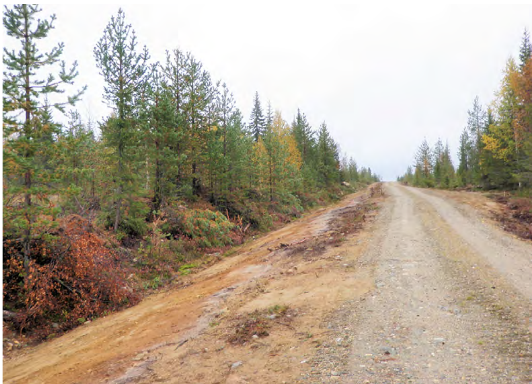
Kuva 86. Tienrakentamisen yhteydessä reuna-alueet maisemoidaan ja työn jäljet siistitään.
