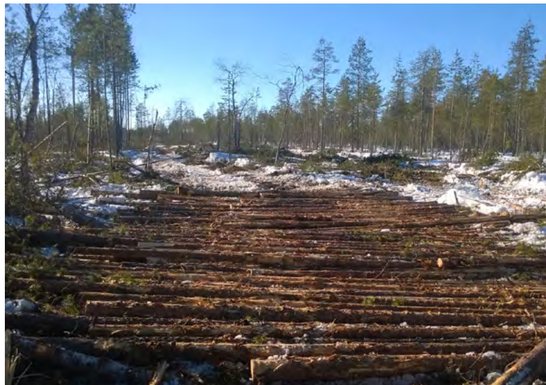
Kuva 56. Haastavalla korjuukohteella on tehty järeä kuitutela maastovaurioiden välttämiseksi. JUHA HÄNNINEN.
