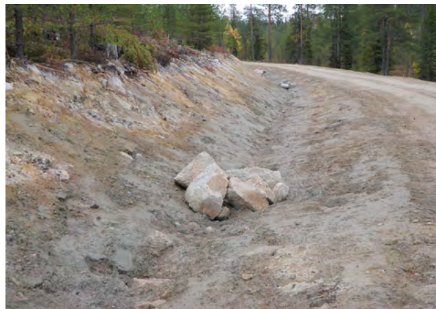
Kuva 85. Kivistä tehdyillä ojakatkoilla voidaan hidastaa veden virtausta ja vähentää ojien syöpmistä. MARKKU TERVONEN.
