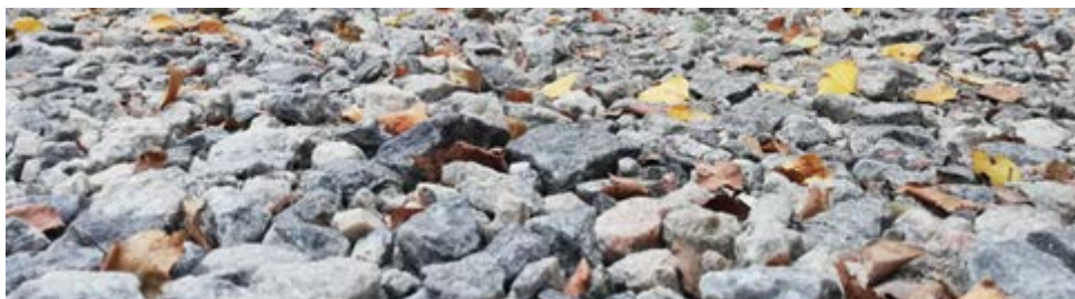
Kuva 22. Liian karkea ja epätasainen alusta on erityisen haastava apuvälineellä kulkevalle. Kuva: Jari Virnes.
