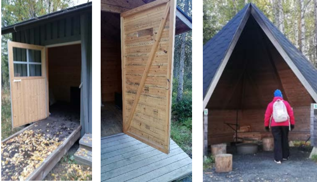
Kuva 17. Esimerkiksi liian matalat tulipesät, vaikeudet liikkua tulipesän ympärillä sekä vaikea pääsy puukatokseen tai käymälään voivat olla haasteellisia tilanteita liikuntarajoitteisille. Kuva: Jari Virnes.
