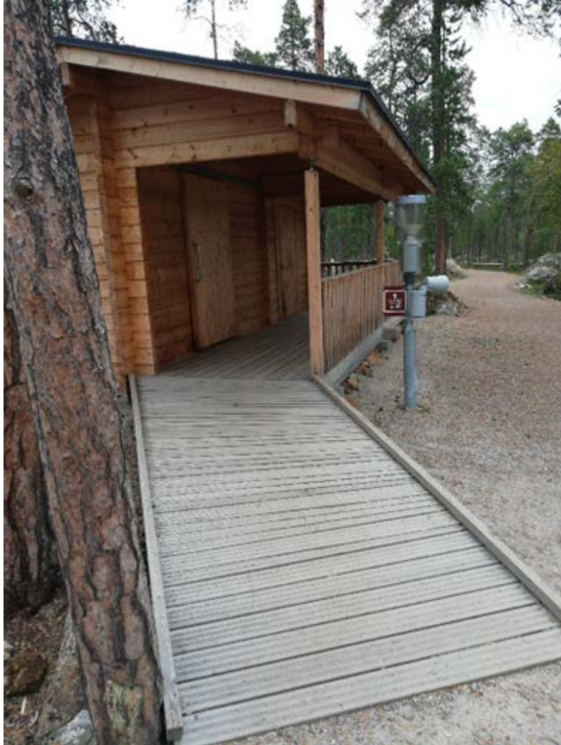
Kuva 33. Juutuan luontopolulla liikuntarajoitteiset pääsevät hyvin polttopuuvarastoon. Kuva: Jari Virnes.
