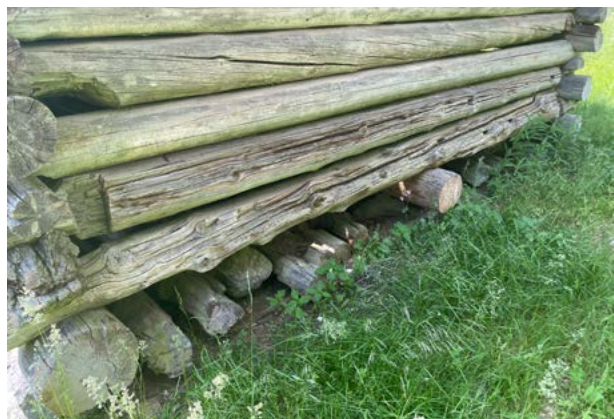
Rakennuksen perustukset ovat matalat, ja osa hirsistä on maata vasten. Kuva: Saatsi Arkkitehdit.
