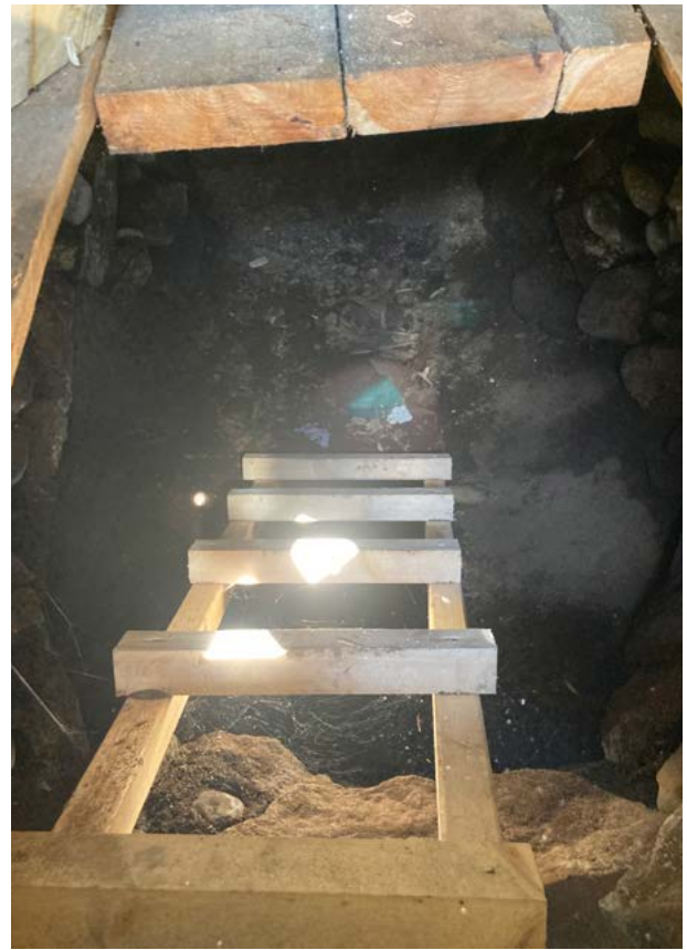
Toisen katoksen kellaritilaa. Kellari on ladottu luonnonkivistä ja sinne johtaa puiset tikapuut. Kuva: Saatsi Arkkitehdit.
