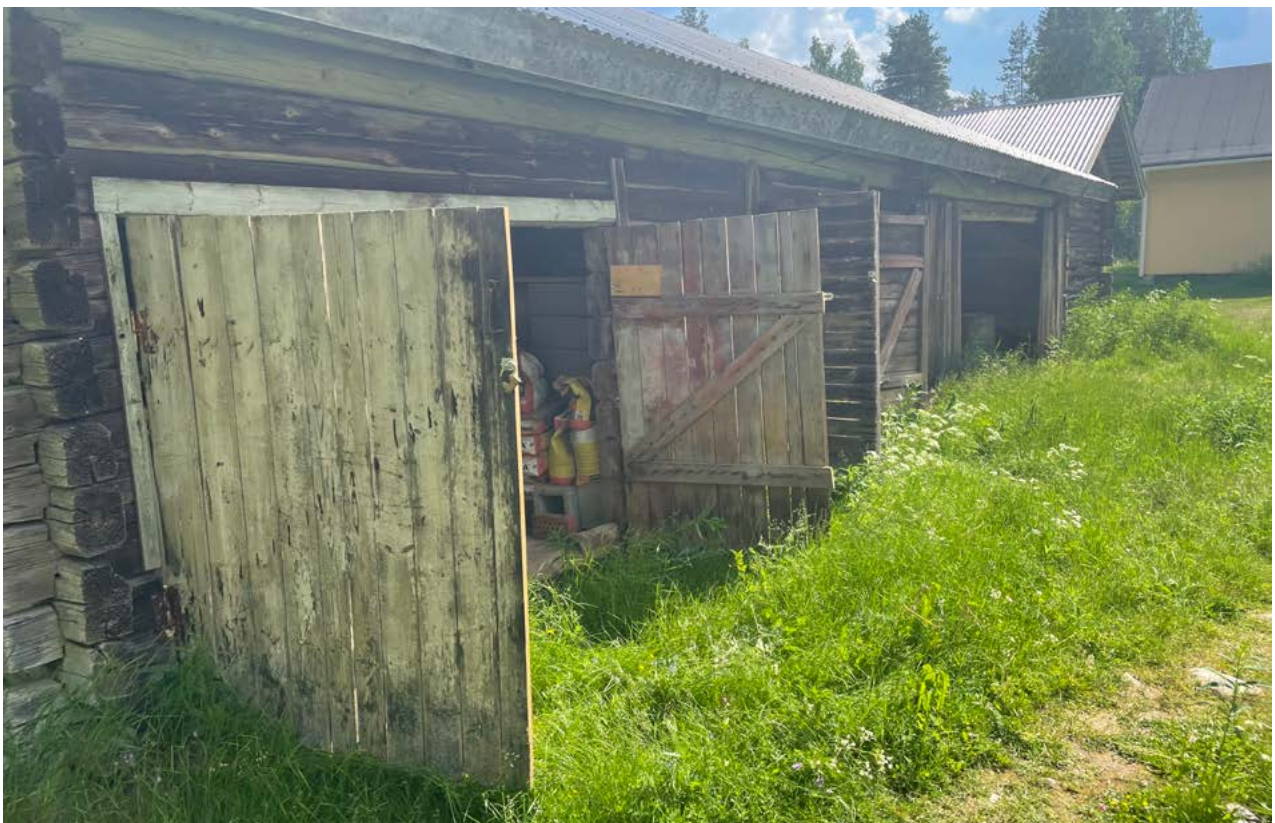
Rakennuksen länsijulkisivulla on leveät pariovet ja kulkuaukko varastoihin. Kuva: Saatsi Arkkitehdit.
