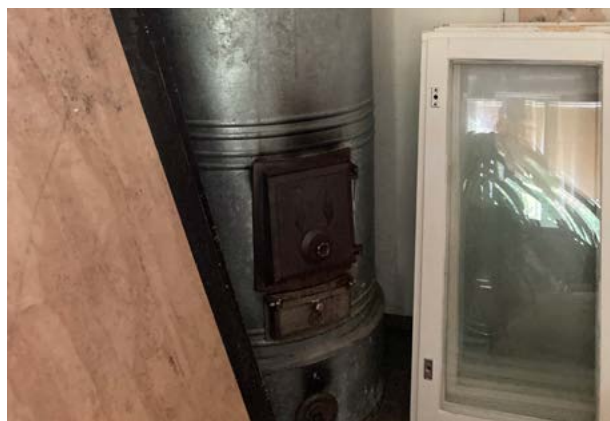
Tilassa on maalaamaton peltikuorinen pönttö-uuni. Kuva: Saatsi Arkkitehdit.
