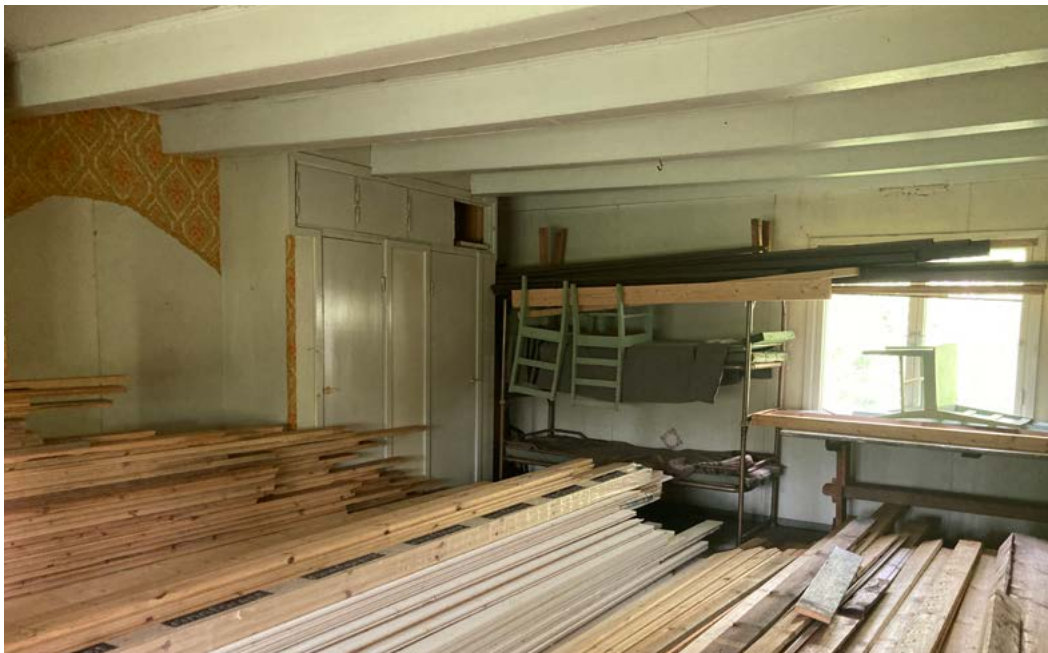
Eteläpäädyn suuri tila. Sisäkaton pinta ja palkit on pahvitettu ja levytetty umpeen. Kuva: Saatsi Arkkitehdit.
