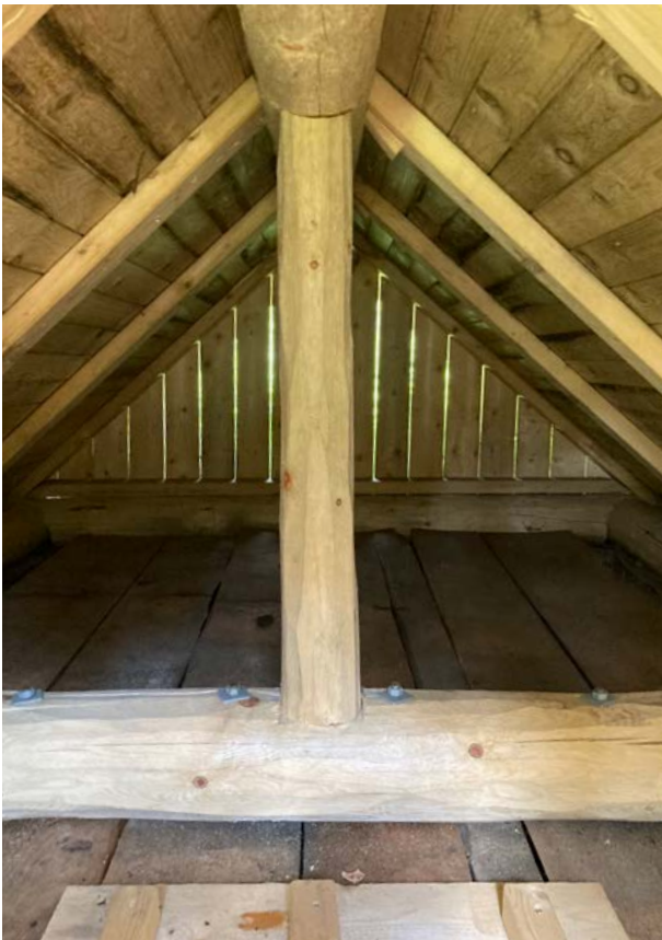
Toisen katoksen sisätilaa. Rakenteet on uusittu kauttaaltaan. Kuva: Saatsi Arkkitehdit.
