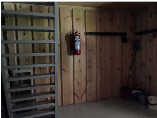
Ensimmäisen huoneen sisäpinnat on vuorattu lomalaudoituksella. Huone on rankarakenteinen. Kuva: Saatsi Arkkitehdit.
