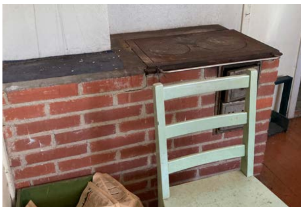
Tilassa on muurattu liesi. Kuva: Saatsi Arkkitehdit.
