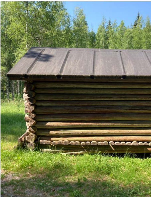
Rakennus kuvattuna idän suunnasta. Hirsissä on näkyvissä jäämiä keittomaalista. Kuva: Saatsi Arkkitehdit.
