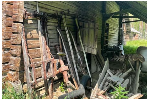
Ulkona katoksessa on jonkun verran tilan toimintaan liittyvää historiallista esineistöä. Kuva: Saatsi Arkkitehdit.
