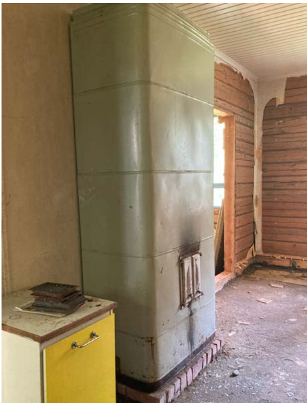
Länsipäädyn huoneessa on peltipäällysteinen muurattu pystyuuni. Lattiat on purettu betonille. Kuva: Saatsi Arkkitehdit.
