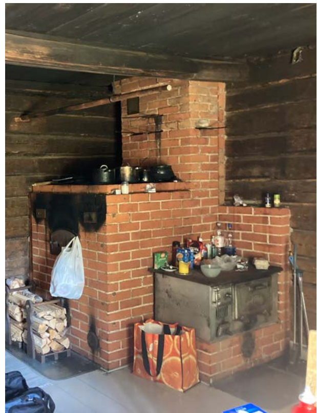
Tuvassa on puhtaaksimuurattu leivinuuni ja liesi. Kuva: Saatsi Arkkitehdit.
