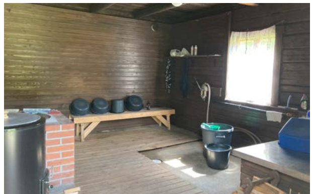
Pesutupa on tilava. Betonilattian päälle on tehty harva laudoitus. Kuva: Saatsi Arkkitehdit.
