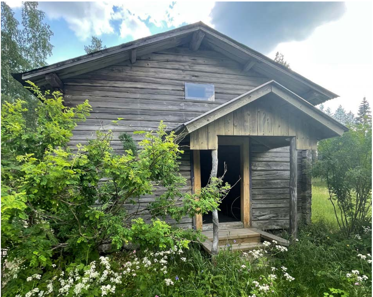
Rakennuksen sisäänkäynti on pohjoispuolelta. Kuva: Saatsi Arkkitehdit.
