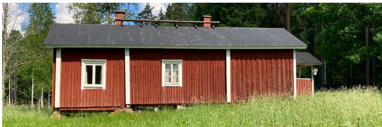
Rakennus kuvattuna etelästä. Sokkelin muutoksista huomaa, kuinka päädyn rakenne poikkeaa keski-osasta. Kuva: Saatsi Arkkitehdit.
