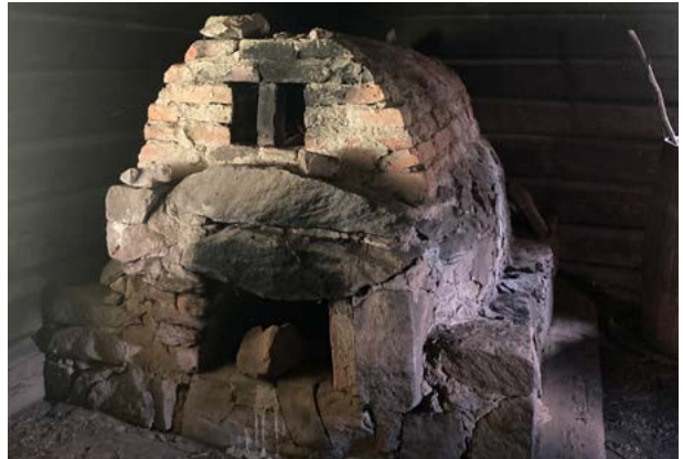
Riihen kiuas on osin melko rapautunut. Kuva: Saatsi Arkkitehdit.
