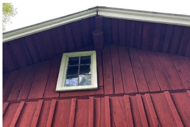
Vintin pienessä ikkunassa on erittäin vanhaa, puhallettua lasia. Kuva: Saatsi Arkkitehdit.
