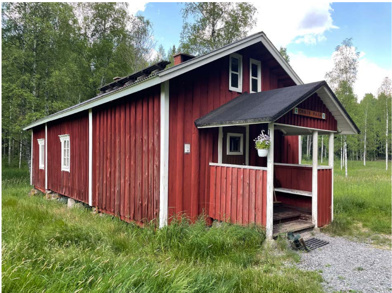
Rakennus kuvattuna kaakon suunnasta. Kuva: Saatsi Arkkitehdit.
