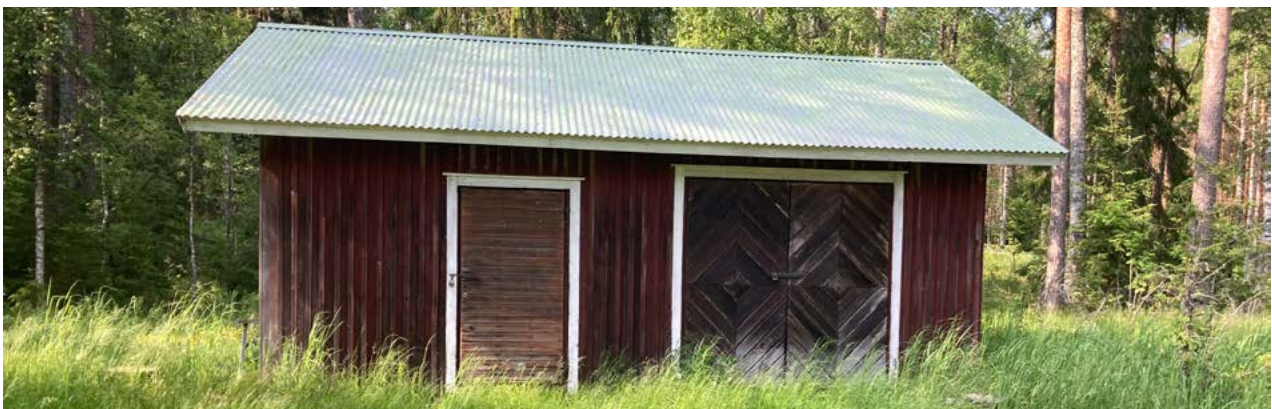
Rakennuksen etelänpuoleinen julkisivu. Ovet johtavat kahteen väliseinällä toisistaan erotettuun varastotilaan. Kuva: Saatsi Arkkitehdit.
