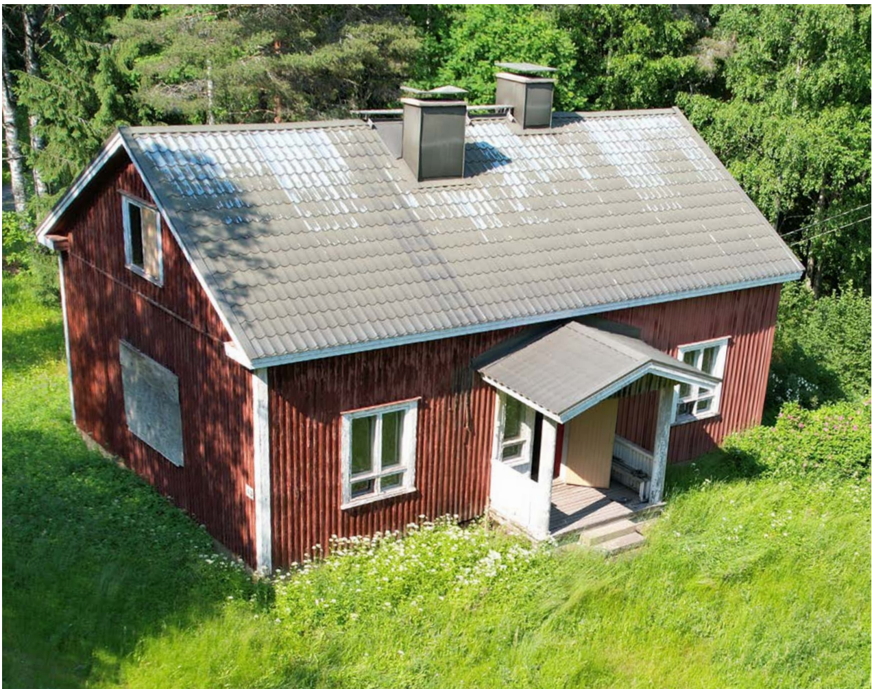
Ilmakuva päärakennuksesta. Kuva: Saatsi Arkkitehdit.
