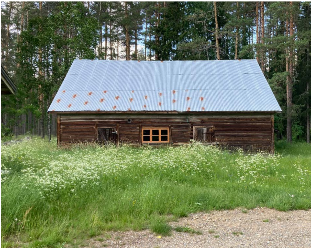
Rakennus kuvattuna etelän suunnasta. Kuva: Saatsi Arkkitehdit.
