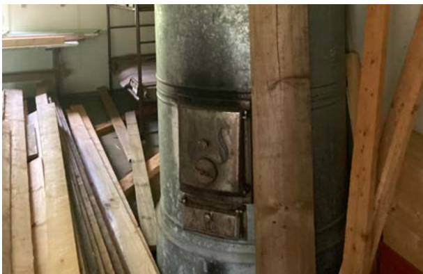
Tilassa on maalaamaton pönttöuuni. Kuva: Saatsi Arkkitehdit.
