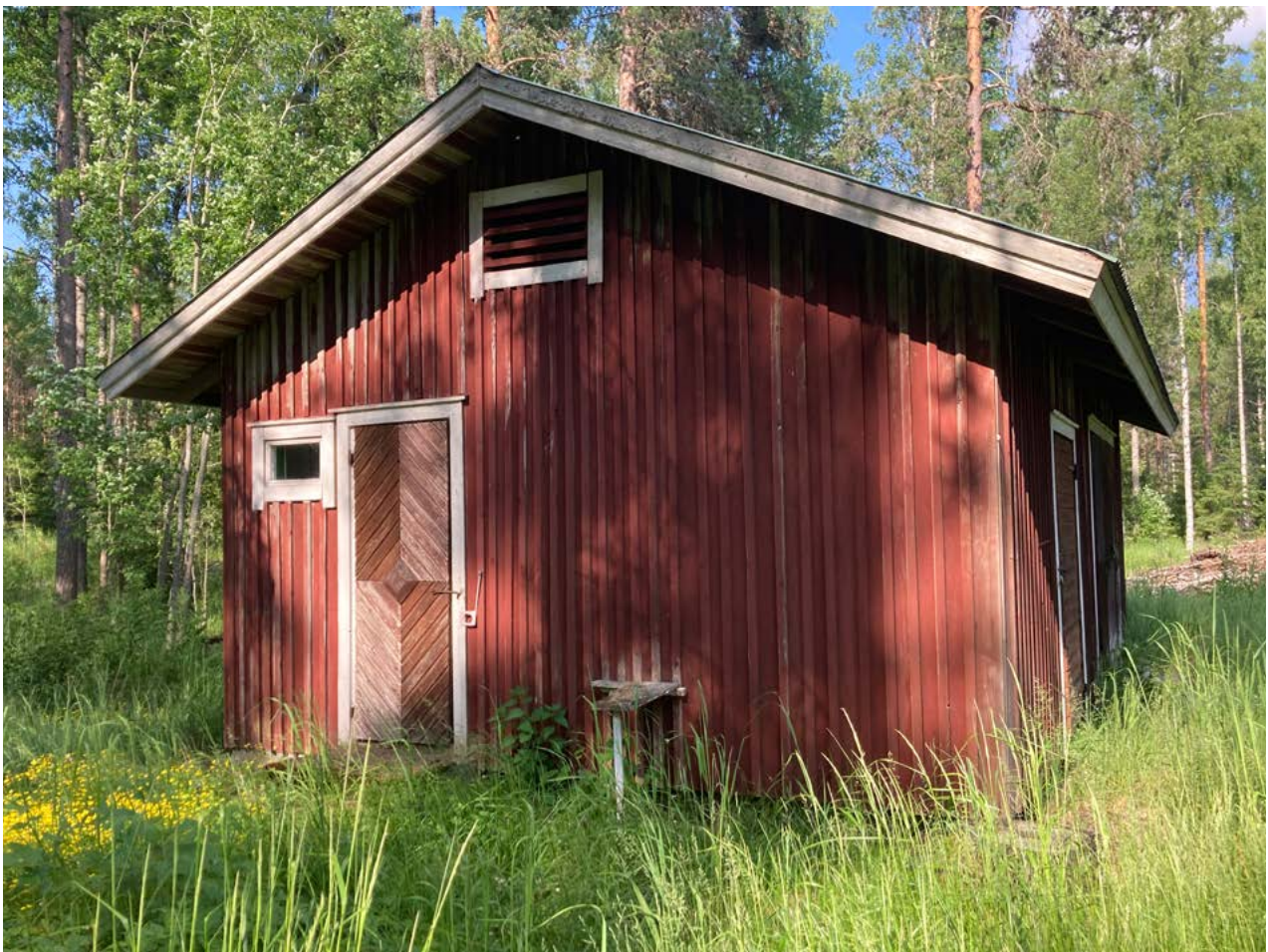
Rakennus kuvattuna lännen suunnasta. Länsijulkisivulla on käymälän ovi ja ikkuna. Kuva: Saatsi Arkkitehdit.
