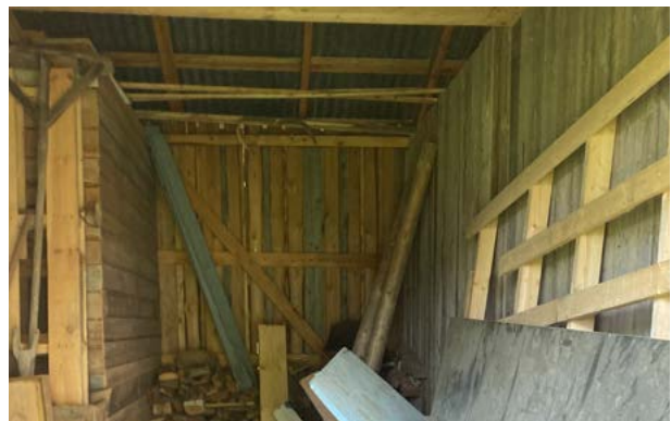
Eteläjulkisivun vasemmanpuoleinen ovi johtaa varastotilaan, jonka nurkasta on erotettu osa ulkokäymäläksi. Kuva: Saatsi Arkkitehdit.
