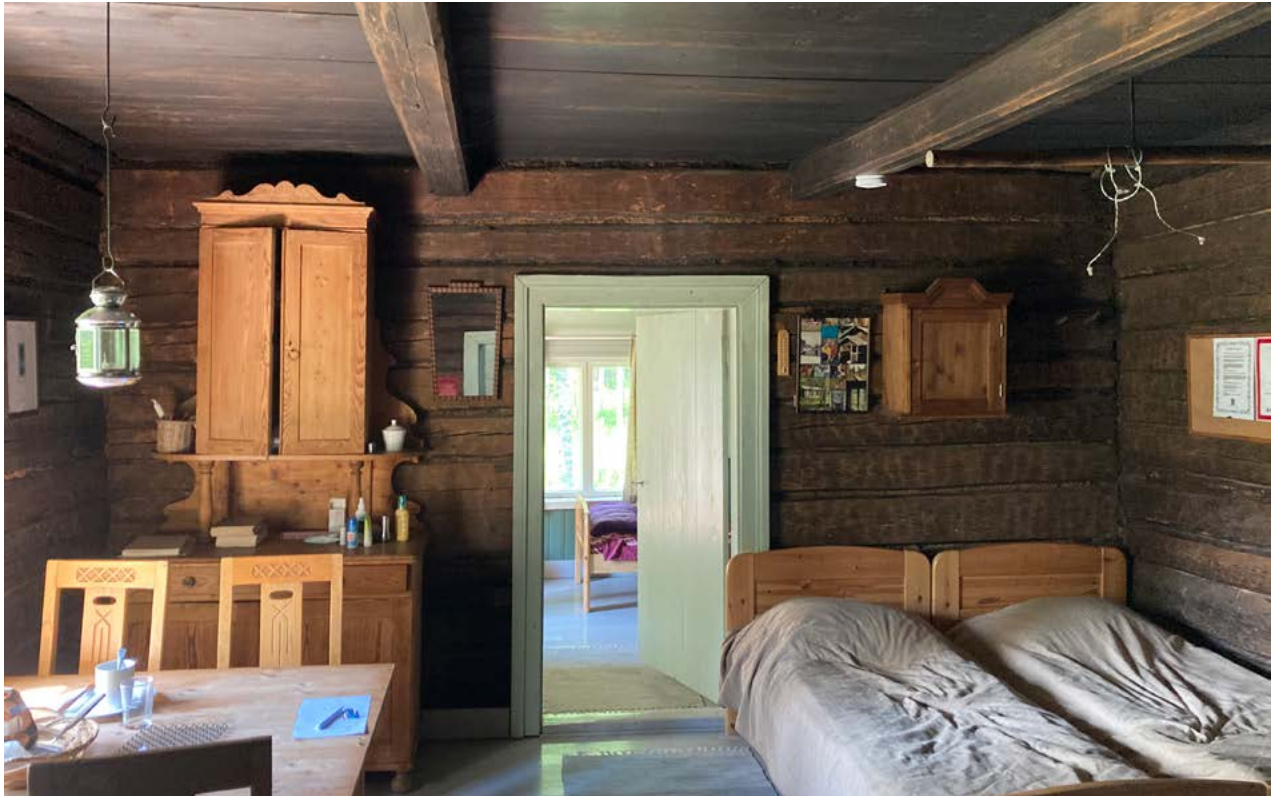
Keskimmäinen tila on riisuttu hirsipinnalle. Avoimesta ovesta näkyy perähuoneeseen. Kuva: Saatsi Arkkitehdit.
