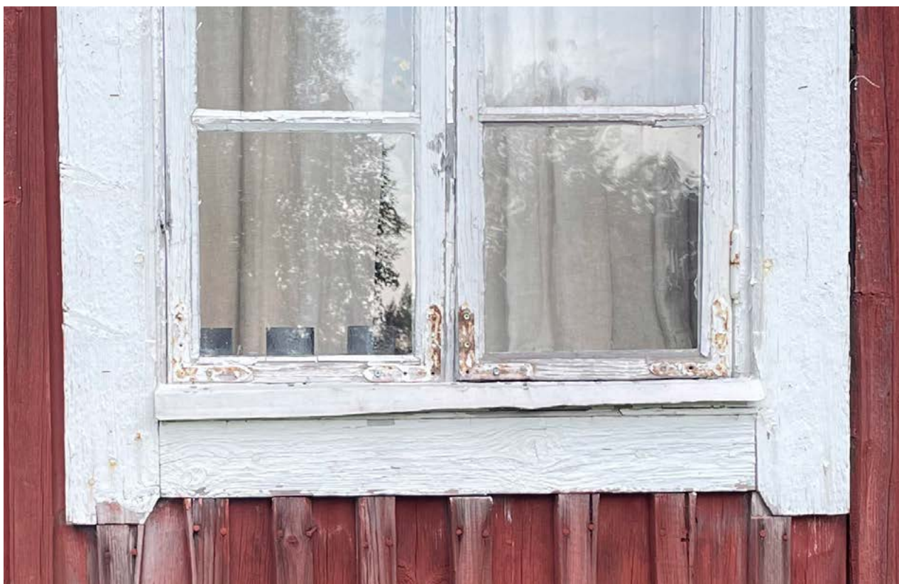
Monissa ikkunoissa maalit ja kitit kesivät, mutta puitepuu on kovaa ja puhalletut lasit ehjät. Onninemajan vuokratupa. Kuva: Saatsi Arkkitehdit.
