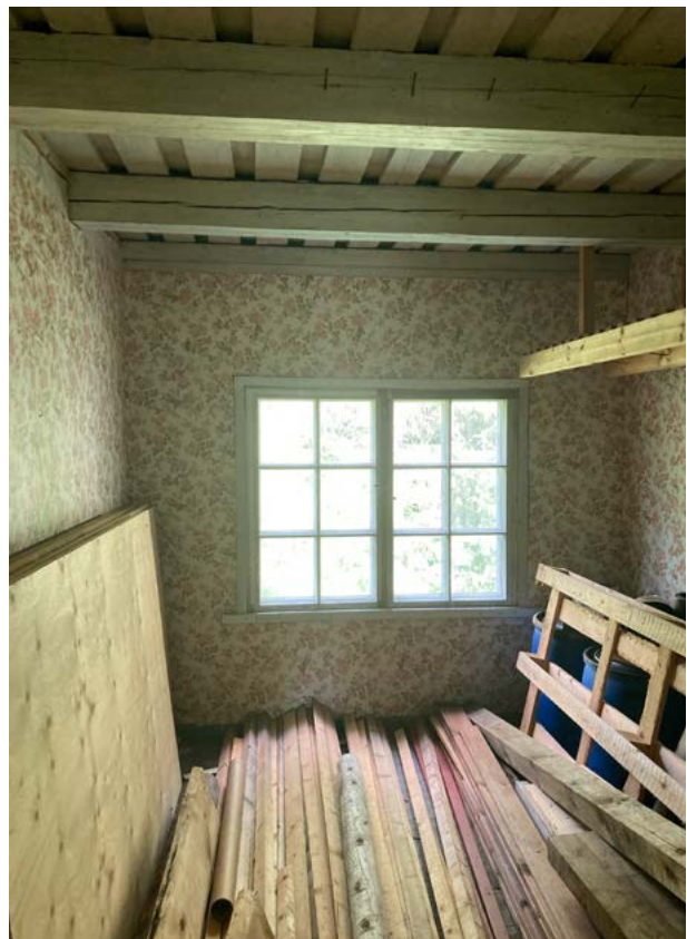
Ruusutapetoidun pienen huoneen lomalaudoitettu sisäkattopinta on näkyvissä. Kuva: Saatsi Arkkitehdit.
