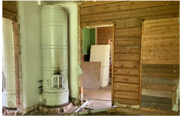
Itäpäädyn huoneissa on pöytäuunit. Rakennuksen sisäpintojen purkujen yhteydessä on paljastunut myös ummistettuja oviaukkoja. Kuva: Saatsi Arkkitehdit.
