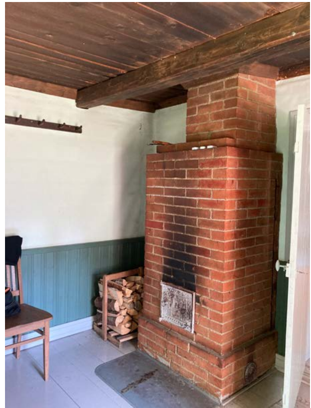
Perähuoneessa on puhtaaksimuurattu tulisija. Kuva: Saatsi Arkkitehdit.
