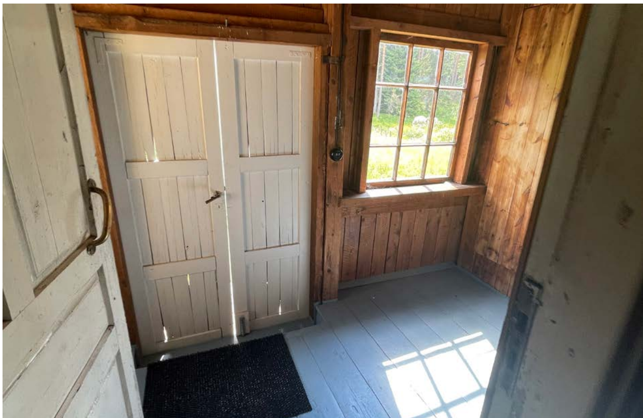
Näkymä eteläjulkisivun kuistilta. Kuistin yhteydessä on portaat vintille. Kuva: Saatsi Arkkitehdit.
