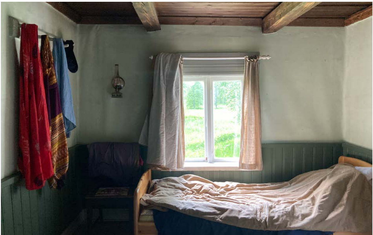
Perähuoneen seinissä on rintapaneelit ja pinkopahvit. Tila toimii makuutilana. Kuva: Saatsi Arkkitehdit.
