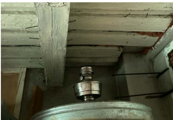
Pönttöuunin yläosaa ja sisäkaton pintaa. Kuva: Saatsi Arkkitehdit.
