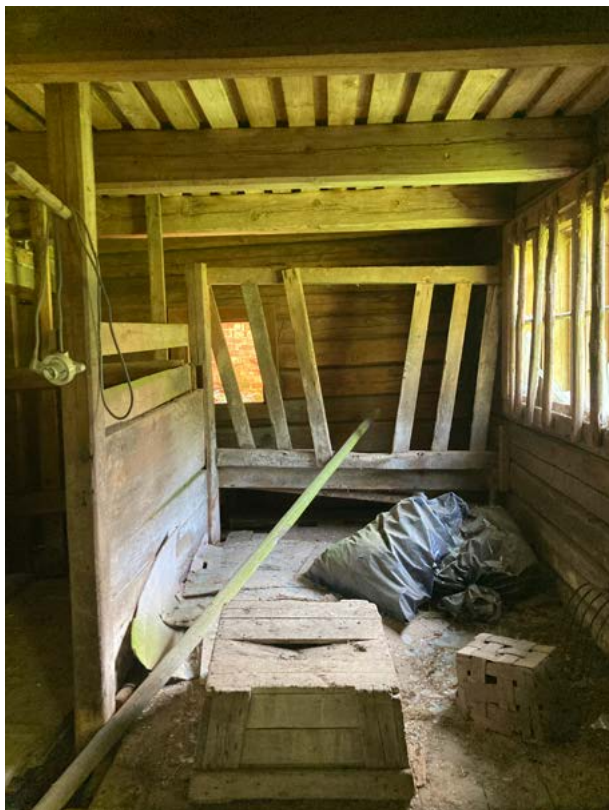
Tilojen katto on pääosin lomalaudoitettu. Kuva: Saatsi Arkkitehdit.
