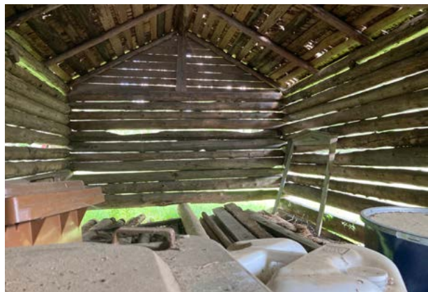
Sisäkuva pohjoispäädyn ladosta. Kuva: Saatsi Arkkitehdit.
