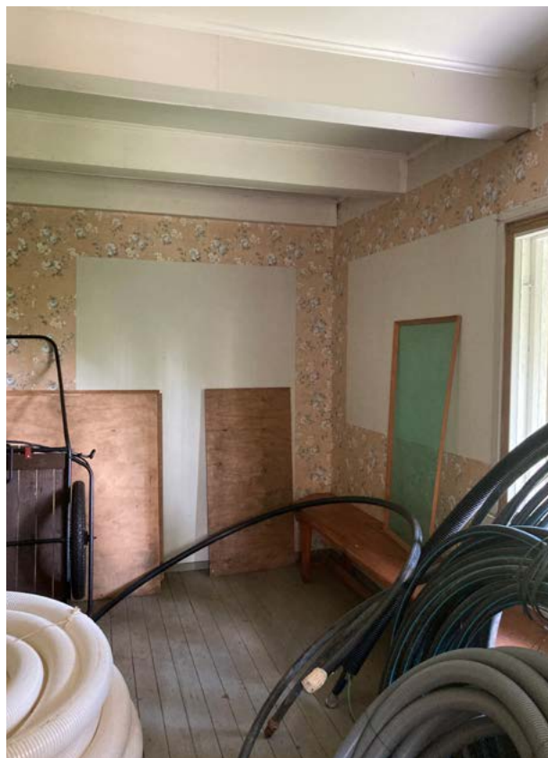
Pohjoispäädyn tilassa sisäkatto on hyväkuntoinen. Kuva: Saatsi Arkkitehdit.
