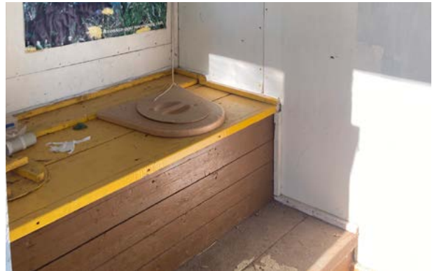
Länsipään ovi johtaa ulkokäymälään. Kuva: Saatsi Arkkitehdit.
