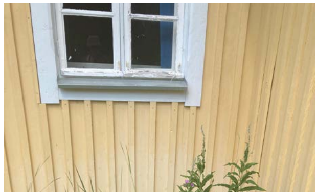
Tuulettuva yläpohja on korkea. Osa yläpohjan täytteistä on poistettu. Kuva: Saatsi Arkkitehdit.
