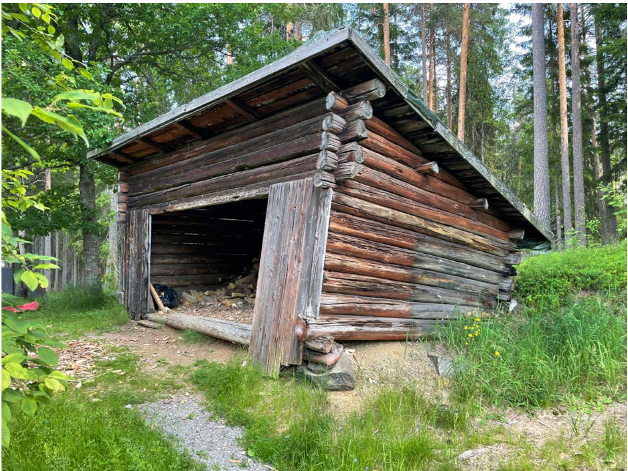
Rakennus kuvattuna etelän suunnasta. Kuva: Saatsi Arkkitehdit.
