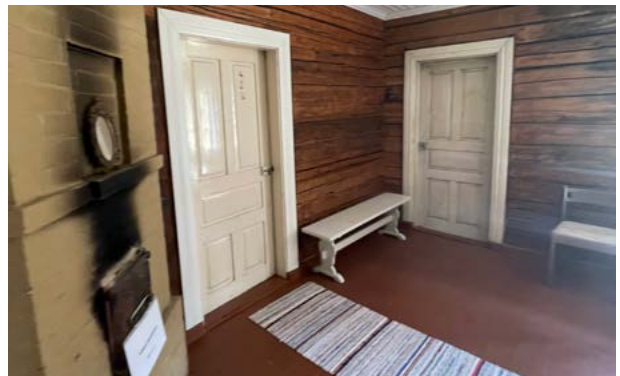
Väliovet ovat alkuperäisiä peiliovia. Kuva: Saatsi Arkkitehdit.
