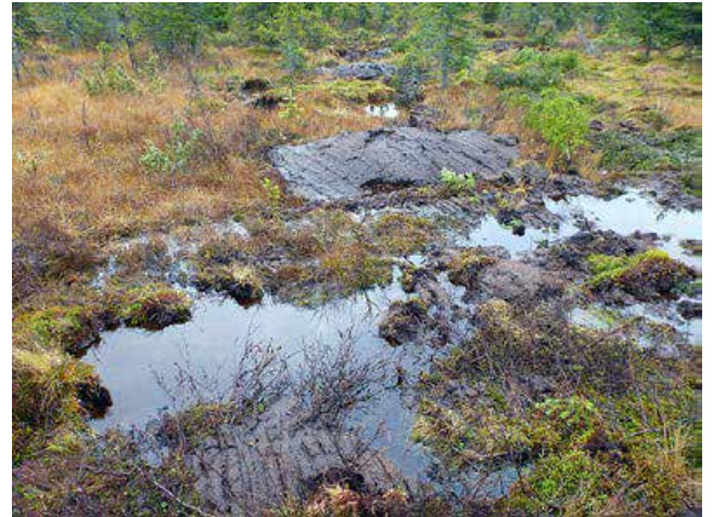
Kuva 33. Salmittunturin lähteisille ja reheville rinnesoille oli kaivettu avo-ojien lisäksi navero-ojia. Suot olivat kuivuneet, mutta puus-toa niille ei ole juurikaan kasvanut. Navero-ojat tukittiin kesällä kaivinkonetyönä turpeella. Taivalkoski 2012. Kuva: Ulla Ahola.
