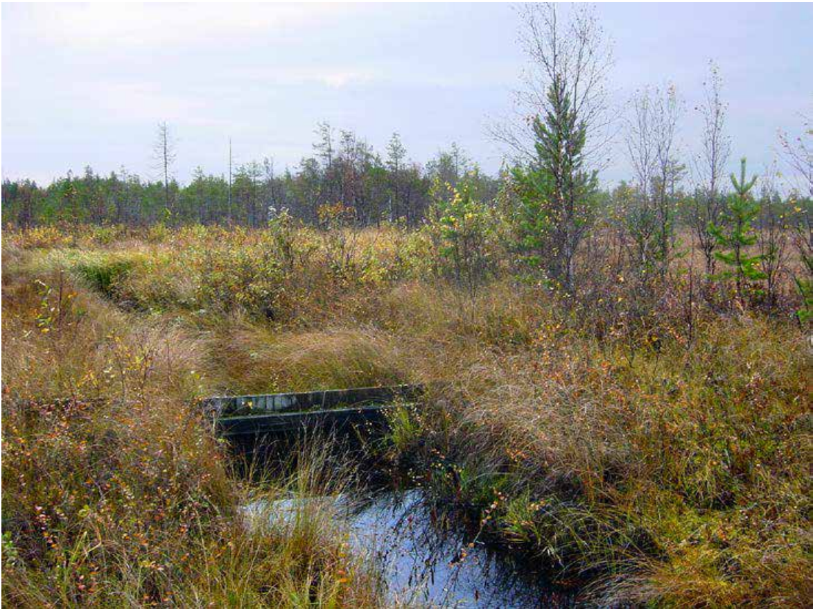
Kuva 22. 1980-luvun lopulla käsin tehty puupato on hidastanut suon kuivumista Venenevällä, Limingassa. Märkyiden vuoksi suolle ei ole asiaa kaivinkoneella. Ennallistamista on myöhemmin jatkettu tekemällä lisää patoja käsityönä. Kuva: Sakari Rehell.
