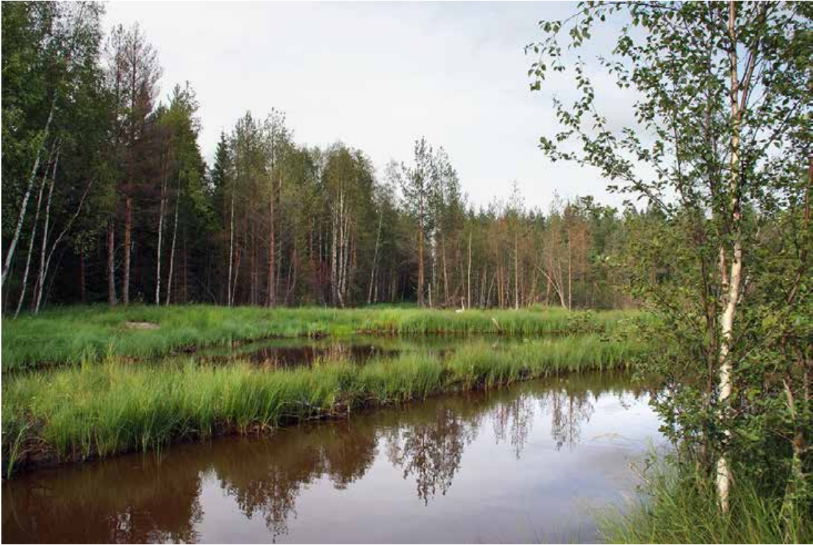
Kuva 134. Alemman suuren padon yläpuolinen lammikko, josta saatiin ainekset taustalla vasemmalla olevan suuren maapadon rakentamiseen. Kuva on otettu kaksi vuotta toimenpiteiden jälkeen. Samalla lammikko ohjaa vedet alueelta katsojan suuntaan kohti Isonvalle johtavaa purouomaa. Kuva: Sakari Rehell, toukokuu 2010.
