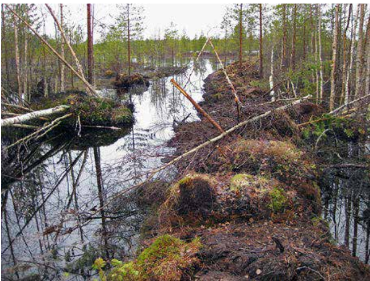
Kuva 96. Edellisen kuvan uomia seuraavana keväänä. Virtaus oli ojassa vasemmalta oikealle. Uoma on kaivettu taustalla näkyvään Hepolamminnevan rimpeen ja pato on kasattu jätteen kohdalle. Kuva: Reijo Hokkanen, 2009.
