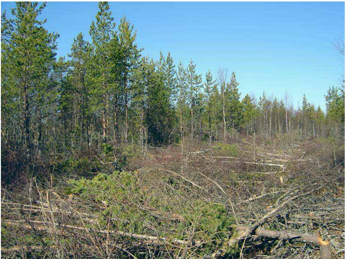
Kuva 23. Kun ojalinjalta raivattavia puuta ei korjata pois, ne ovat yleensä aina enemmän tai vähemmän kaivinkonetyön tiellä. Tällä kohteella monitoimikone kaatoi raivatut puut ojan poikki, joten puiden siirtely hidasti kaivinkoneen työtä. Koneella olisi voinut koota kaadetut puut esimerkiksi nipuiksi ojan viereen. Kuva: Sakari Rehell.
