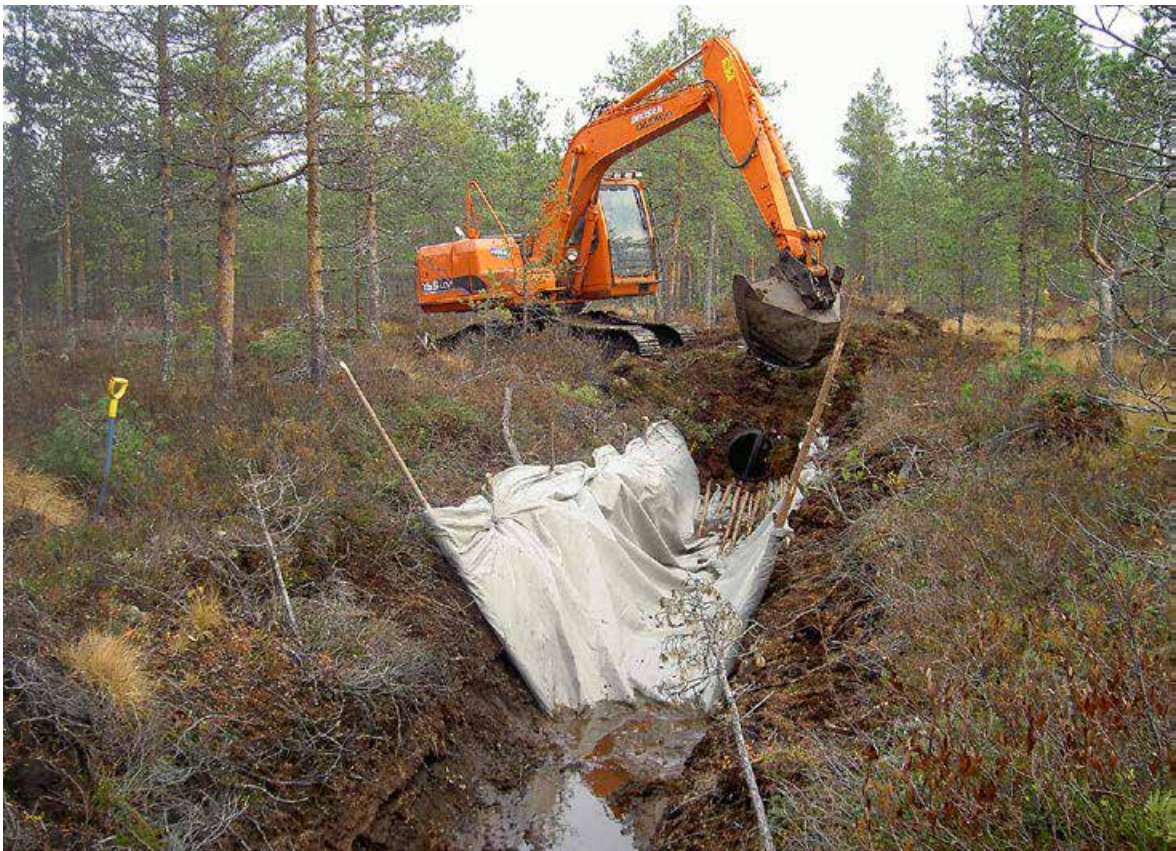
Kuva 147. Putkipatoa rakennetaan Pohjavedenpinnan nostamiseksi vuonna 2010 Vaalassa Rokuan hiekkamuodostuman reunalla. Ensinnäkin rakennettiin alin pato pohjavesialueen ulkoreunalle. Tämän jälkeen tehtiin vastaavia patoja yläpuolelle siten, että kunkin padon kohdalla on vain vähäinen porras vedenkorkeudessa. Kuva: Mikko Tölli.
