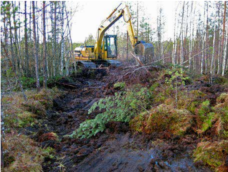
Kuva 95. Kaivinkone kaivamassa yhtä neljästä uomasta, joilla vedet ohjataan Hepolamminnevan itäreunan ojasta suolle. Hepolamminneva hämöttää koneen takana. Kuva: Reijo Hokkanen, 2008.
