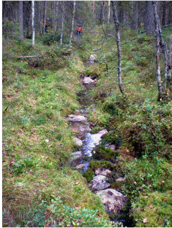
Kuva 82. Pohjavettä virtaavassa ojassa vedenpintaa on nostettu ja uomaa tehty monimuotoisemmaksi. Aiemmin suorassa ojassa vesi kulki syvällä ojan pohjalla, eikä sitä juuri näkynyt. Pohjapadoilla on hillitty veden virtausta ja saatu aikaan suvantoja ja pieniä koskipaikkoja. Suvantopaikoissa sammalilla on mahdollisuus levittäytyä kivien ja puiden pinnoille. Kuva: Sari Kaartinen, syyskuu 2009.
