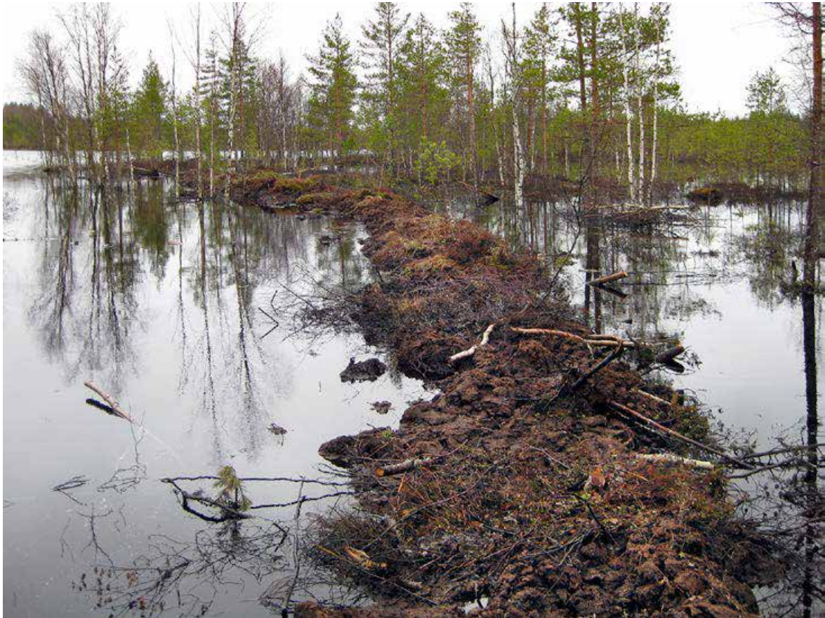
Kuva 97. Hepolamminnevan jänteelle tehtiin noin 50 m pitkä pato. Nevan suurin rimpi (5 ha) on kuvassa vasemmalla, veden laskusuunta vasemmalta oikealle Hepolampeen päin. Kuva: Reijo Hokkanen, 2009.
