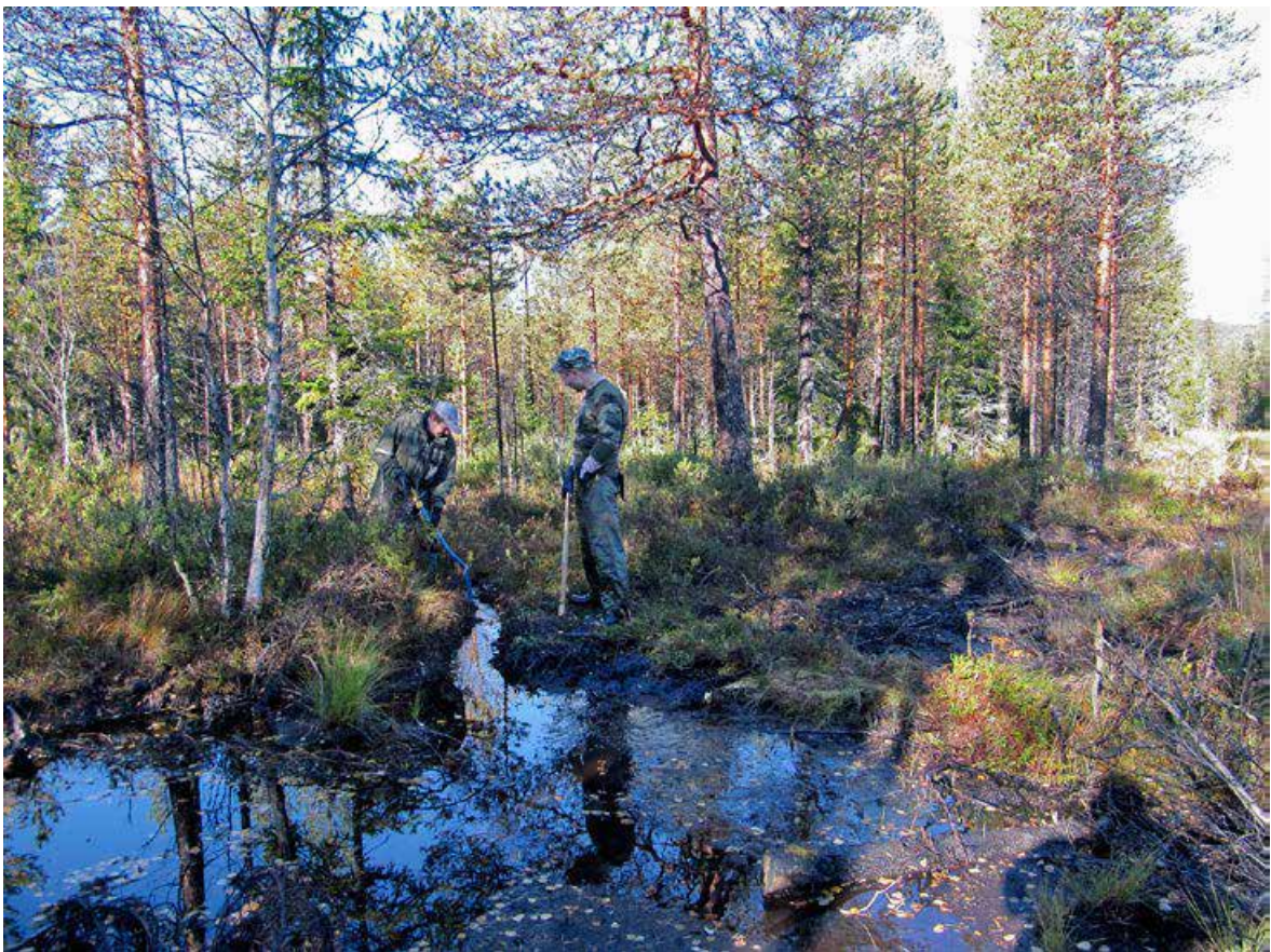
Kuva 76. Vesi ohjautuu saralle ja ojalinjalle tehty pato pitää. Kuva: Mika Puustinen 2010.
