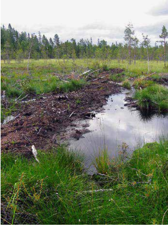
Kuva 26. Itämäen märällä nevilla ojalinjat jäivät täytön jälkeenkin sarkapintaa matalammalle, joten ojalinjalla on täytön jälkeen runsaasti vettä. Tilanne osattiin ennakoida, joten pintavalleja tehtiin tiheästi ja vesi saatiin niiden avulla leviämään suolle. Pyhäntä 2008. Kuva: Sari Kaartinen.
