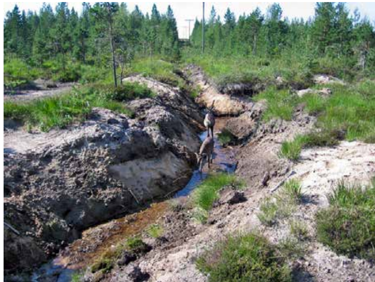
Kuva 137. Jäkälävaaran rinnesuon syvälle syöpyneitä ojia ennen ennallistamista. Oikealle kääntyvään haarakohtaan tehtiin tukeva puuvahvisteinen ja suodatinkankaalla vahvistettu pato sekä sen yläpuolelle noin 5–10 metrin päähän lisäksi kangasvahvisteinen maapato. Kuva: Sari Kaartinen 2007.
