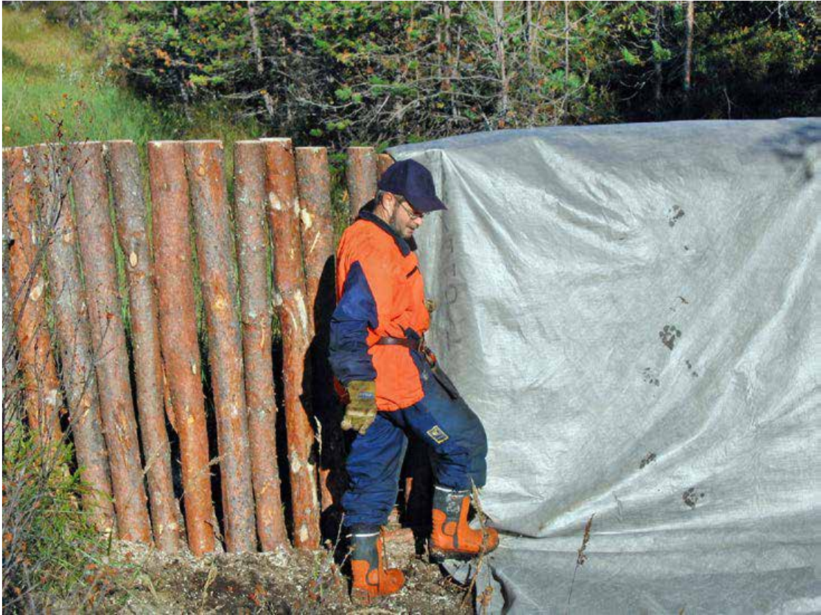
Kuva 109. Koska kanava oli hyvin syvä, jouduttiin puupadoistakin tekemään poikkeuksellisen korkeita. Kuva: Pekka Veteläinen, elokuu 2005.
