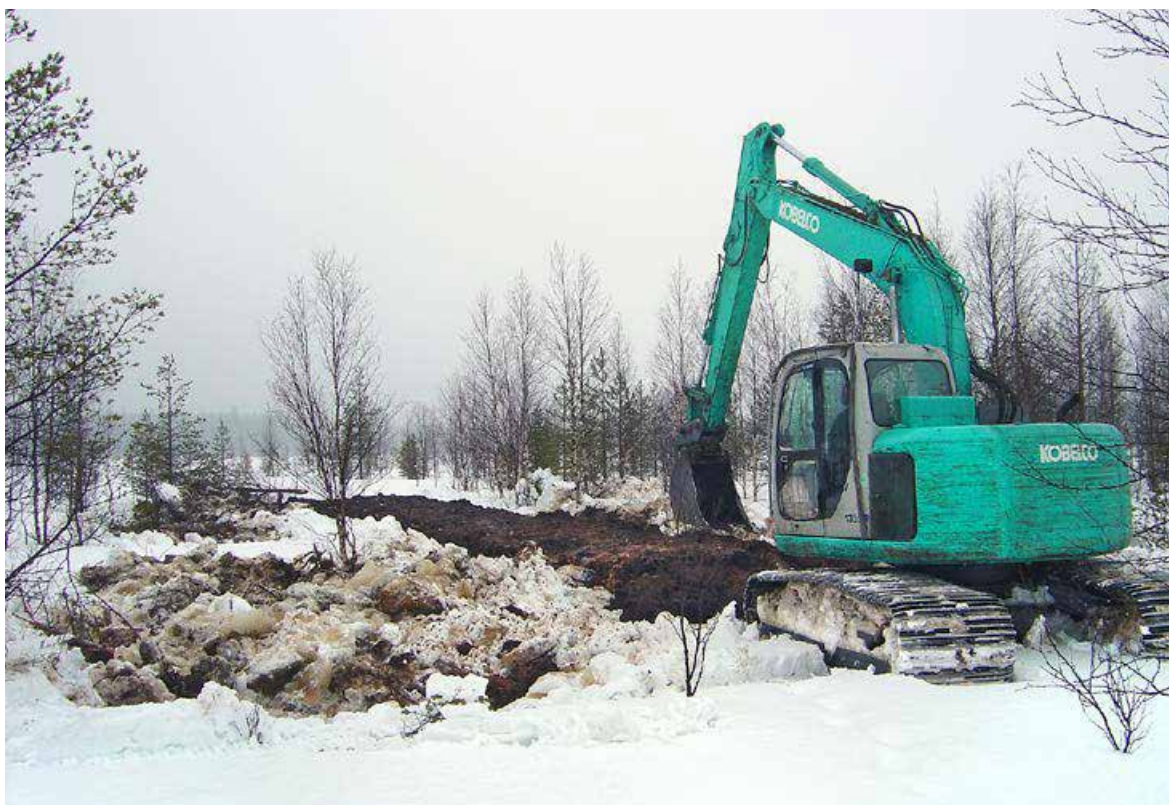
Kuva 39. Kuivaniemen Lähteenaaapa on märkä aapasuo, jonka reunoja alettiin ennallistaa 1990-luvun lopulla. Useiden ojakilometrien osalta jouduttiin turvautumaan käsin tehtyihin patoihin, koska suo oli liian märkä konetyöhön. Suo ei lähtenyt ennallistumaan toivotulla tavalla, joten ojat päätettiin padota konetyönä talvella. Aluksi suon pinnalta kuorittiin jää, jotta saatiin esiin patoihin käytettävä turve. Suo on verrattain tasainen, joten 20–30 metriä leveille patovalleille voitiin jättää paikoin väliä yli 100 metriä. Käsintehty padot jätettiin ennalleen. Toimenpide paransi suon ennallistumisketystä huomattavasti. li 2007. Kuva: Sakari Rehell.
