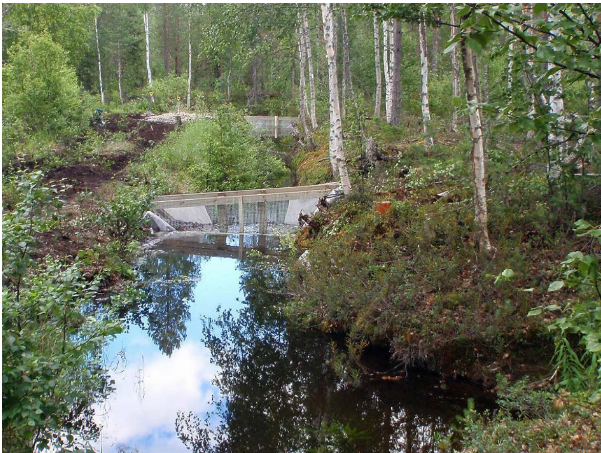
Kuva 146. Siirassuolla veden pintaa nostettiin voimakkaasti virtaavassa (2 000 m 3 /vrk) ojassa isoilla kulutusta kestäville pohjapadoilla. Alueen maalaji, pitkälle maatunut turve, ei olisi kestänyt patomateriaalina voimakasta virtausta. Pato tehtiin pakkaamalla metalliverkon sisään murskettä, joka suojattiin suodatinkankaalla ja yläreunaltaan kuormapeitteellä. Oja verhoiltiin kivillä alemman padon alapuolelta ojan pohjan syöpmisen estämiseksi. Kuva: Virve Kupiainen.
