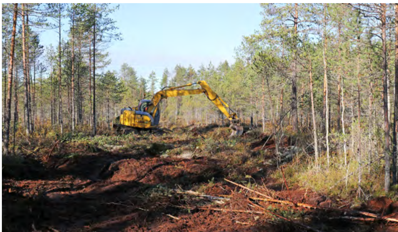
Ennallistettavaa rämettä, jonka ojat tukittiin kaivinkoneella. Kuva: Maarit Similä.
