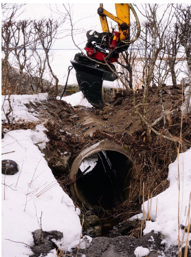
Kuvat 17 ja 18. Verkvikfladanin tierumpu ennen ja jälkeen kunnostuksen. Kuvat: Maija Haukkala ja Anette Bäck / Metsähallitus.
