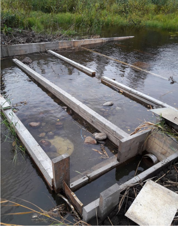
Kuva 36. Kluuvin johtava kalaporras helpottaa kalojen nousua kutualueelle keväällä. Kuva: Sanna Kuningas / Luonnonvarakeskus.
