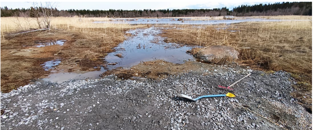
Kuvat 15 ja 16. Långvikenissä toimenpiteen tavoitteena oli sulkea kaksi keinotekoisia kanavaa ja palauttaa luonnollinen uoma sekä kynnys. Työssä käytettiin sekä paikallista että muualta kuljetettua kiviaineista, savea ja soraa. Kuvat: Ralf Wistbacka.
