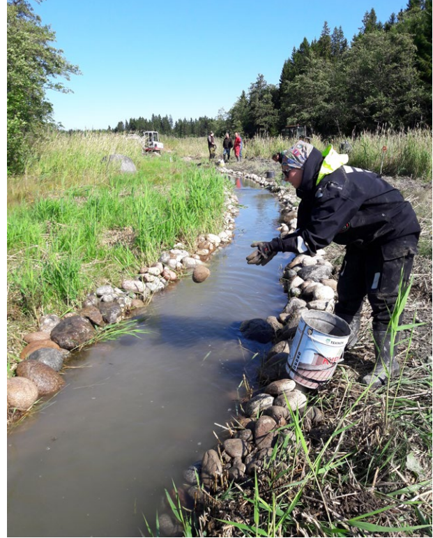
Kuva 37. Uoman pohjaan laitetaan kiviä estämään nopea ruovikon uudelleen kasvu. Kuva: Sanna Kuningas / Luonnonvarakeskus.
