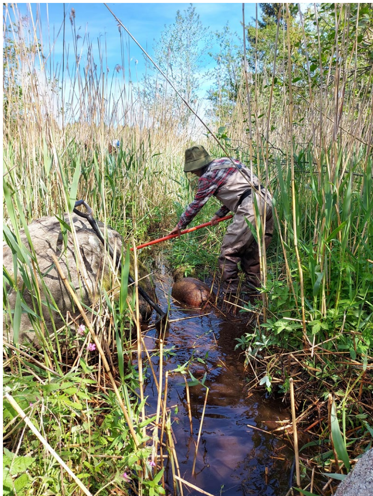
Kuva 23. Dollosverkanin uoma avattiin viikatteella ja pirunkouralla. Kuva: Anette Bäck / Metsähallitus.
