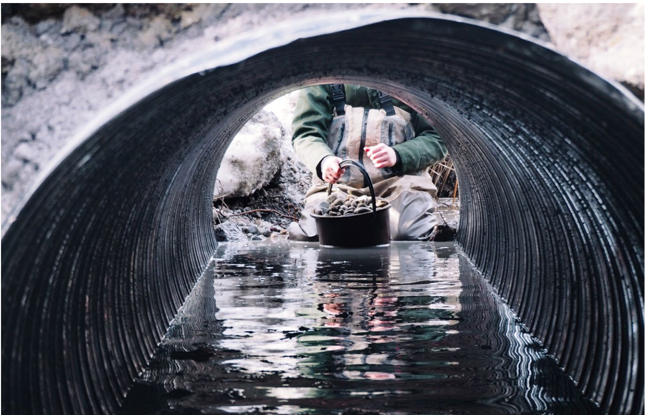
Kuva 19. Tierumpu laskettiin maahan ja täytettiin soralla ja kivillä, jotta uomalle saatiin mahdollisimman luonnollinen jatkumo. Kuva: Maija Haukkala / Metsähallitus.
