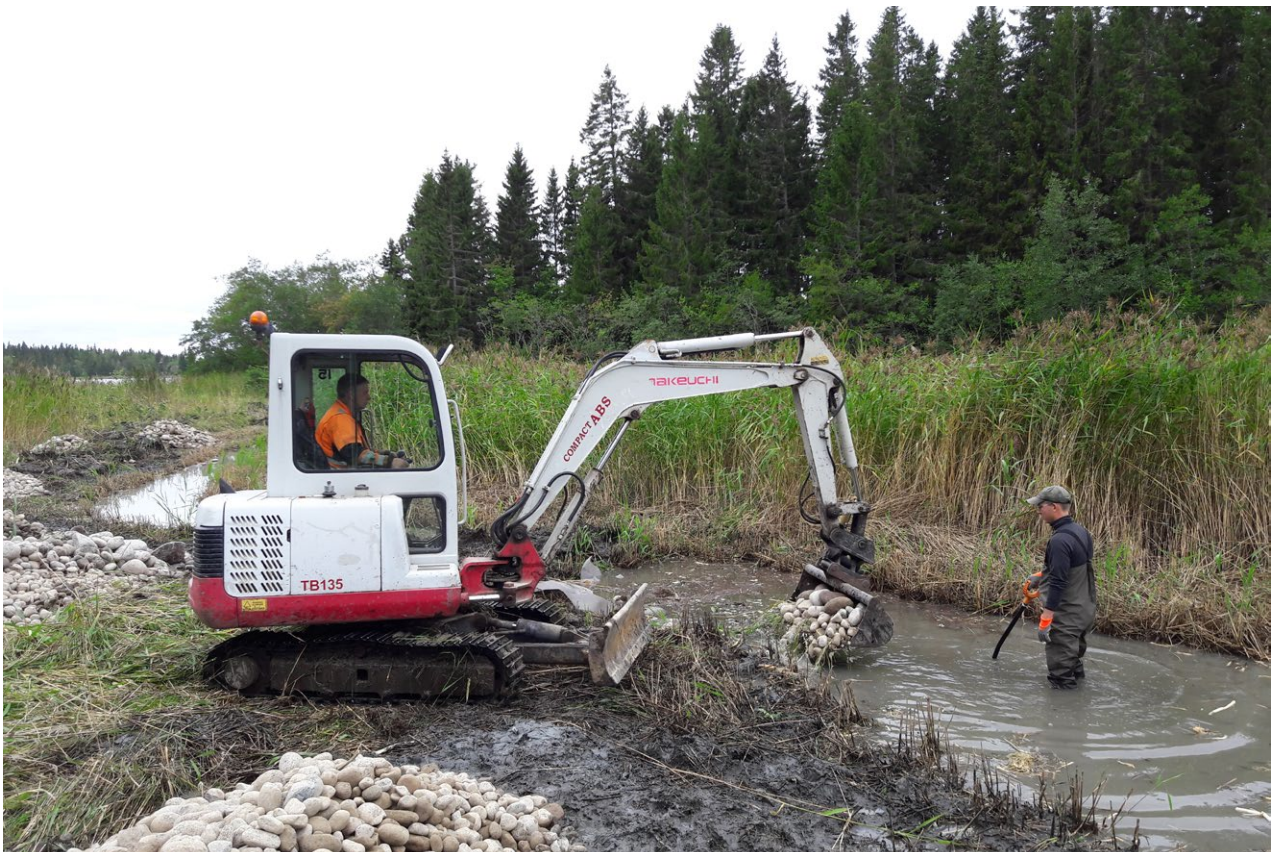
Kuva 38. Uomaan asetellaan runsaasti kivimateriaalia. Kuva: Sanna Kuningas / Luonnonvarakeskus.
