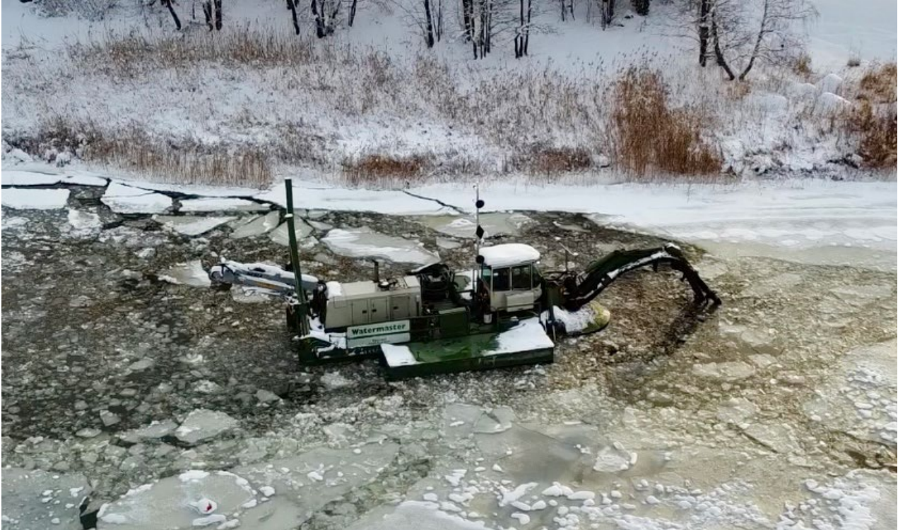
Kuva 10. Sedimentin imuruoppausta Haminan Pappilansaarten salmissa. Kuva: Harri Huuho / MeriHamina ry.
