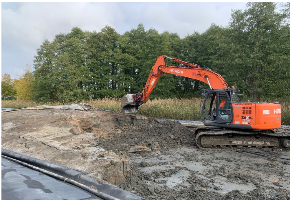
Kuva 12. Geotuubissa tiivistynyttä ruoppausmassaa, jota voidaan ominaisuuksista riippuen käyttää esimerkiksi viherrakentamisessa. Kuva: Harri Huuho / MeriHamina ry.
