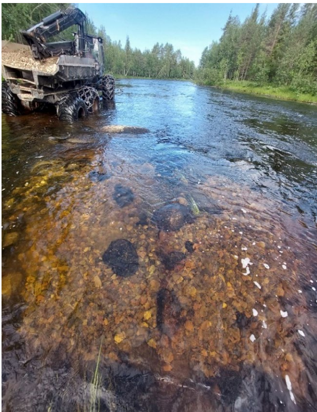
Kuvat 11–12. Lisätyt kutusoraikat Vikajoen Seitenoikiassa (kuva 11) ja Livojoen Hanhikoskella (kuva 12). Kuva 11: Antero Mölläri. Kuva 12: Matti Suanto.
