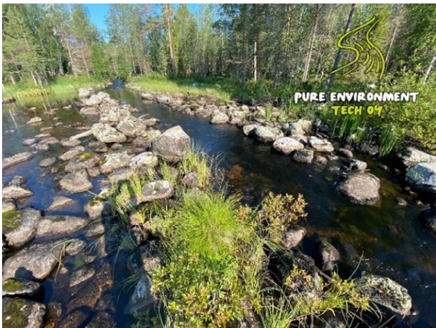
Kuvat 6–7. Ennen-jälkeen-kuvat peratun kiviaineksen palauttamisesta ja soraikon teosta Silmäjoella (kuva 6 ennen ja kuva 7 jälkeen). Kuvat: Pure Environment Tech Oy.
