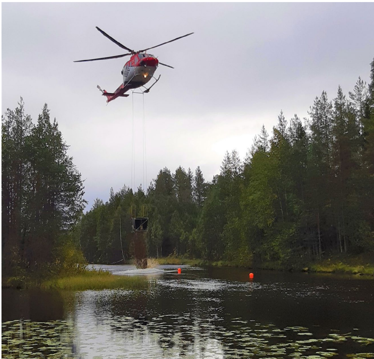
Kuva 10. Livojoen Niskakosken kutuelinympäristöjen teko helikopterityönä. Kuva: Eero Hartikainen.
