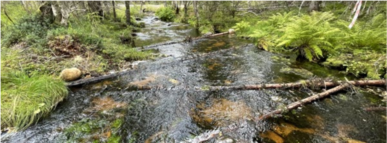
Kuvat 24–26. Poika-Loukusan ojalla uomaan lisättiin rantapuuston valtalajeja kuusta ja koivua (kuva 24 ennen puuaineksen lisäämistä ja kuva 25 puiden lisäämisen jälkeen). Kuvassa 26 poikkisuisteet Mätäsojalta. Kuvat: Antti Karppinen.
