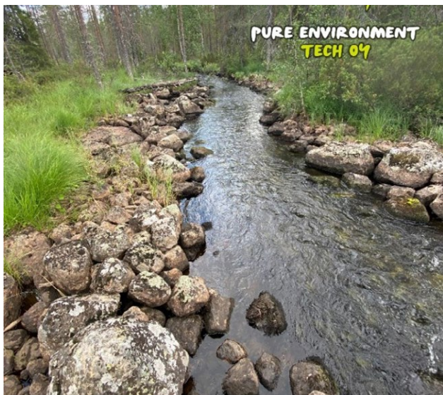
Kuvat 8–9. Ennen-jälkeen-kuvat peratun kiviaineksen palauttamisesta ja soraikon teosta Naarmajoella (kuvat 8 ennen ja kuva 9 jälkeen). Kuvat: Pure Environment Tech Oy.
