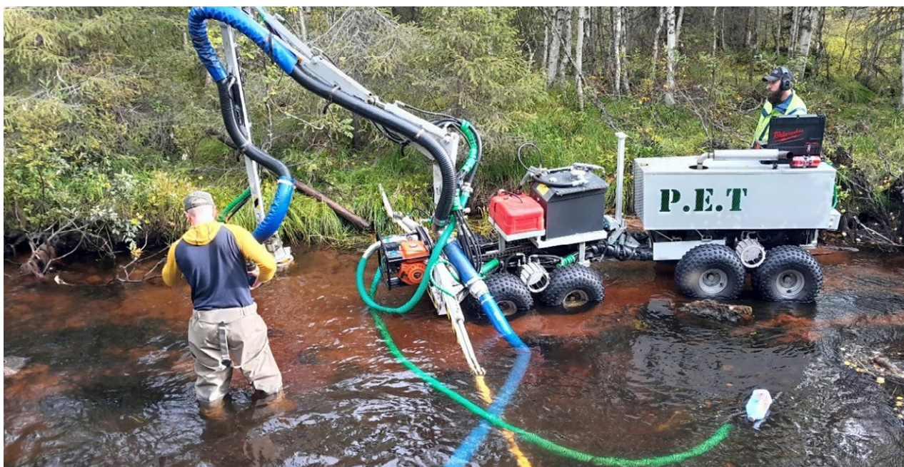
Kuva 33. Yhteistyöyrittäjän kehittämä imuruoppauskalusto Perttausjoella. Kuva: Sihveri Ervasti.
