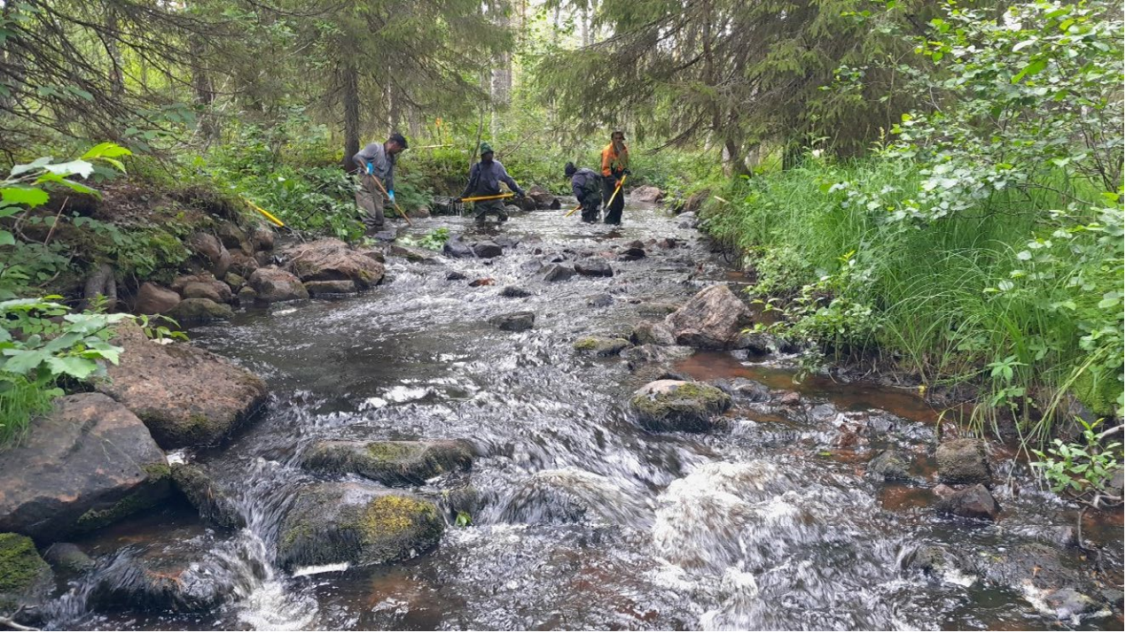
Kuva 15. Kutusoraikkojen kunnostamista ja lisäämistä Hartijoki-menetelmällä Silmäjoella. Kuva: Sihveri Ervasti.
