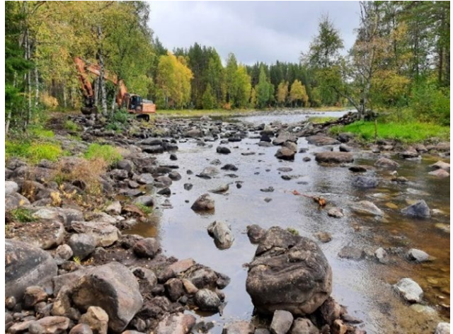
Kuvat 22–23. Uittopatorakenteita purkamalla ja sivu-uomia kiveämällä parannettiin uoman virtausolosuhteita Lieksanjoen Siikakoskella (kuva 22 ennen ja kuva 23 jälkeen). Kuvat: Veijo Honkanen.
