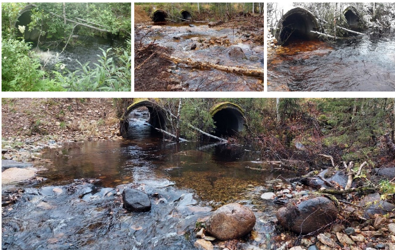
Kuvat 27–30. Poika-Loukusan ojan tierummun esteellisyys poistettiin kynnyksellä rummun alapuolelta uomaa (kuva 27 ennen ja 28–29 jälkeen). Kynnyksen eteisaltaaseen rakennettiin kutusoraikkoja (kuva 30). Kuva 27: Esteet Pois! -hanke, kuva 28: Joonas Fontell, kuvat 29–30: Antti Karppinen.
