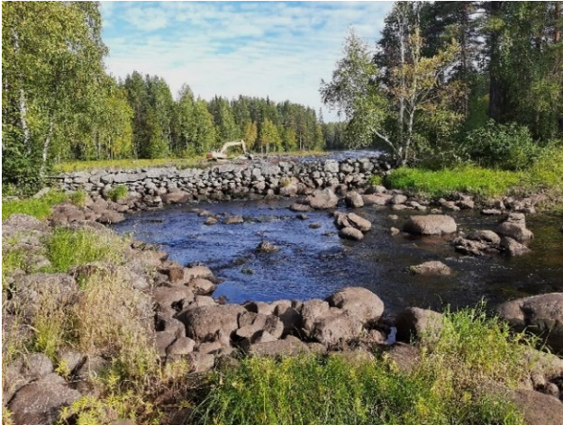
Kuvat 22–23. Uittopatorakenteita purkamalla ja sivu-uomia kiveämällä parannettiin uoman virtausolosuhteita Lieksanjoen Siikakoskella (kuva 22 ennen ja kuva 23 jälkeen). Kuvat: Veijo Honkanen.
