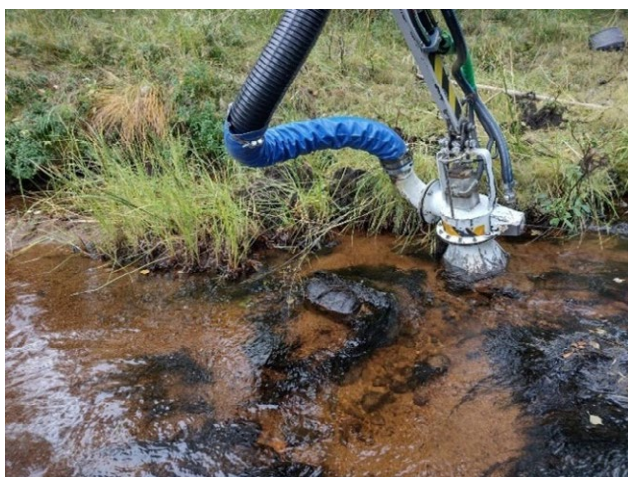
Kuvat 31–32. Ennen-jälkeen-kuvat Perttausjoelta, jossa imuruoppauksessa poistettiin kivikon peittävä hiekkakerros (kuva 31 ennen ja kuva 32 jälkeen imuruoppauksen). Kuvat: Sihveri Ervasti.
