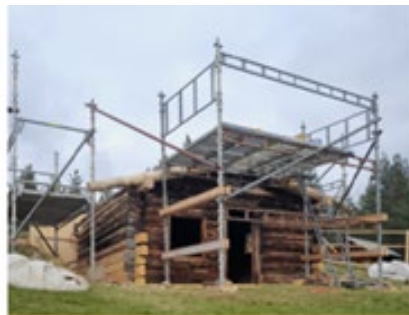
56,7 % Urakoiden kokonaishinnasta kohdentui puurakennuksiin tai pienrakennuksiin.
