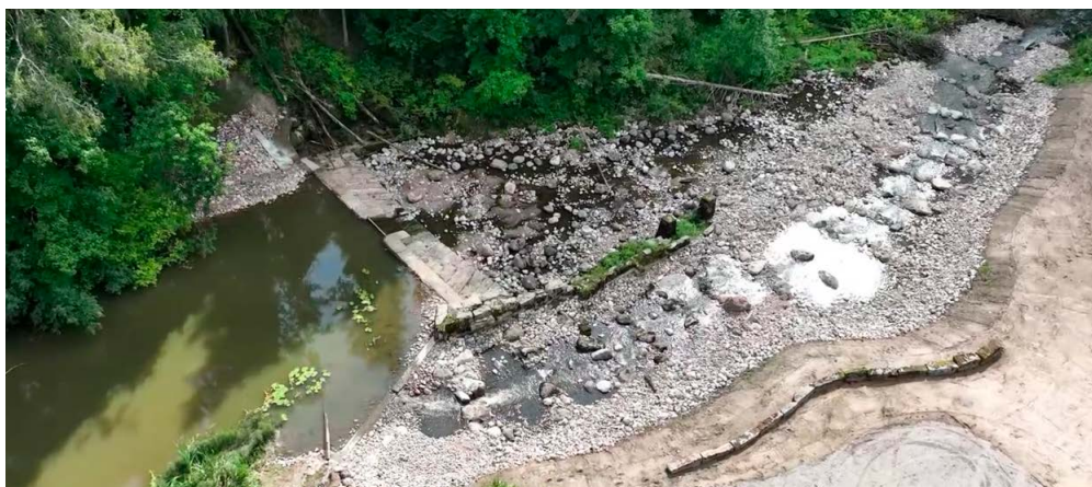
I Sibbo å byggdes en naturlig vandringsväg vid Broböle kvarndamm.
