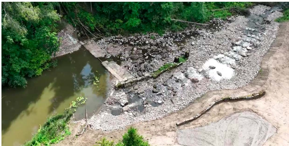
Sipoonjoella rakennettiin Brobölen myllypadolle luonnonmukainen ohitusuoma.
