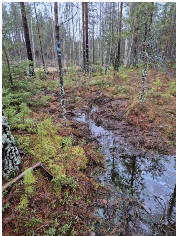
Kuva 177. Johdeoja ei riittänyt vetämään loppusyksyn 2024 tulvavesiä. Kuva: Johanna Ruusunen.
