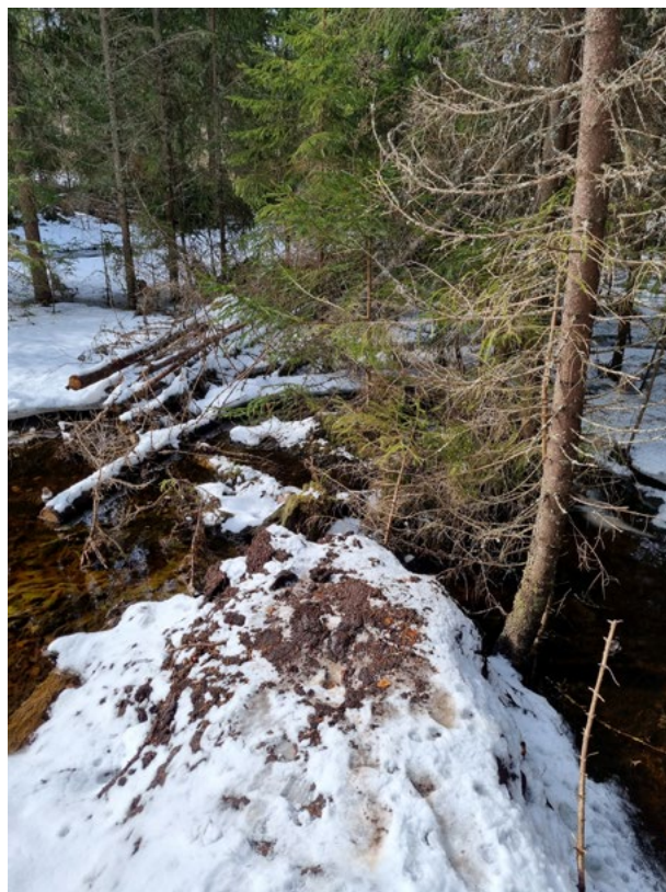
Kuva 173. Ab-ojan pohjoispään pintavalli oli osin pettänyt voimakkaiden syystulvien seurauksena. Kuva: Johanna Ruusunen.
