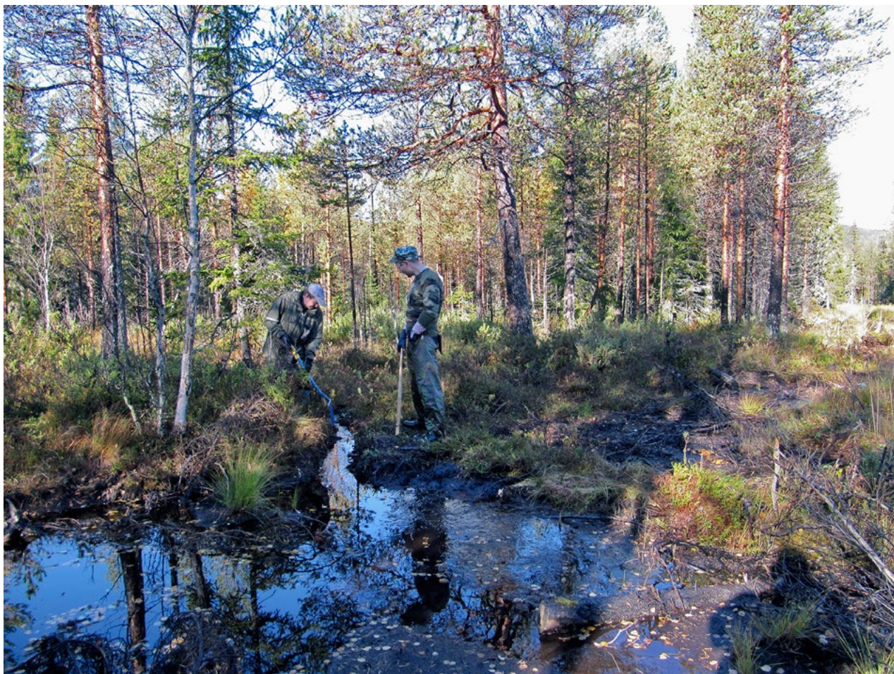
Kuva 104. Vesi ohjautuu saralle ja ojalinjalle tehty pato pitää. Kuva: Mika Puustinen 2010.
