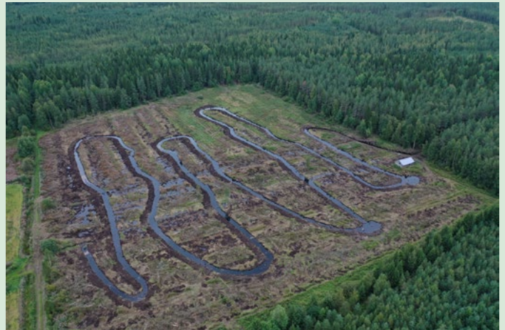
Kuva 5. Vähäjärven Niittuperä 2 -suopellolle kaivettu mutkitteleva, purouomaa jäljittelevä loivapiirteinen oja heti töiden jälkeen. Kuva: Jari Vähäsalo.
