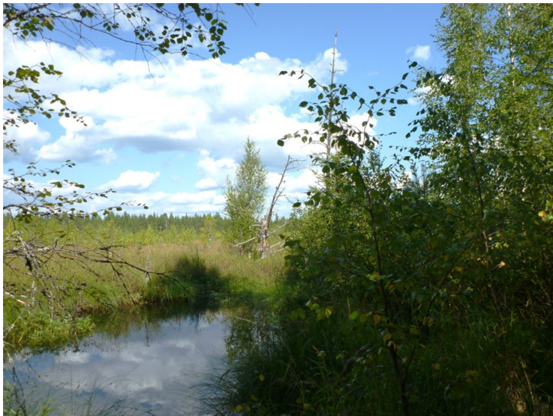
Kuva 194. Kuvassa oikealla on lähes 15 vuotta aiemmin tehty patovalli. Vasemmalle puolelle on muodostunut lammikko kohtaan, josta patoaines on otettu. Vedenpinta on noussut suolla paikallisesti, ja monet ravinteisuutta suosivat suokasvit, kuten tupasvilla ja kastikat, ovat runsastuneet. Suolle on silti ilmaantunut taimikko. Kuva: Sakari Rehell.
