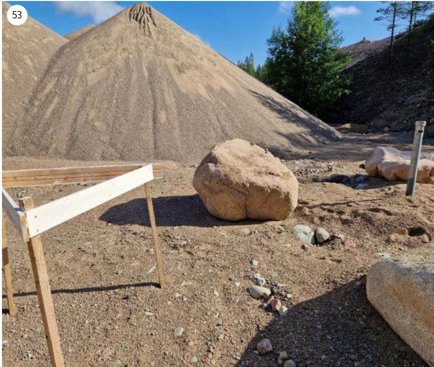
Kuvat 53–54. Kiviainesalueelle sijoitettavan korkomerkin (vasemmalla) avulla varmistetaan, ettei ottamistoiminta ulotu työn aikana suunniteltua syvemmälle. Pohjavesiputkesta seurataan ottamistoiminnan aikana pohjaveden pinnankorkeutta ja pohjaveden laatua (kuva 53). Polttoaineen varastointia kiviaineskohteessa valuma-altaalla varustetussa kontissa (kuva 54). KUVAT: PÄIVI LAAKSO.
