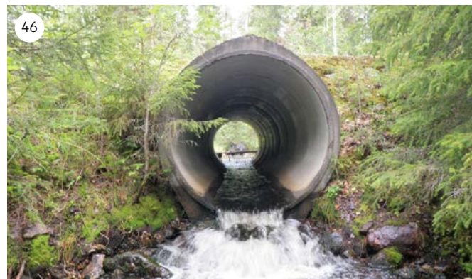
Kuvat 45–46. Metsätien rakentamista (kuva 45) ja vaellusesteen aiheuttava vesistörunnu (kuva 46). KUVA 45: MIKKO TÖRMÄNEN, KUVA 46: METSÄHALLITUS / ESTEET POISI! -HANKE.
