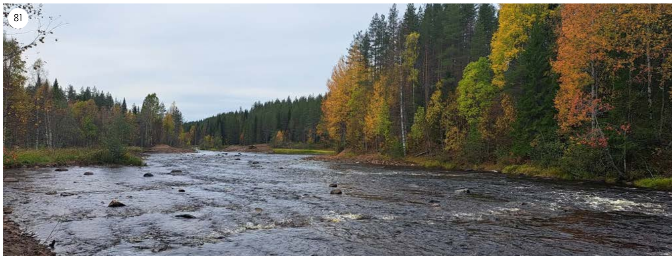
Kuvat 80–81. Laajamittainen virtavesikunnostus Livojoella. Uittovallin päältä on poistettu puut ja käynnissä on vanhan uoman siivous sekä maa-aineksen läjittäminen maa-alueelle (kuva 80). Sama alue kunnostusten jälkeen (kuva 81). KUVAT: EERO MOILANEN.
