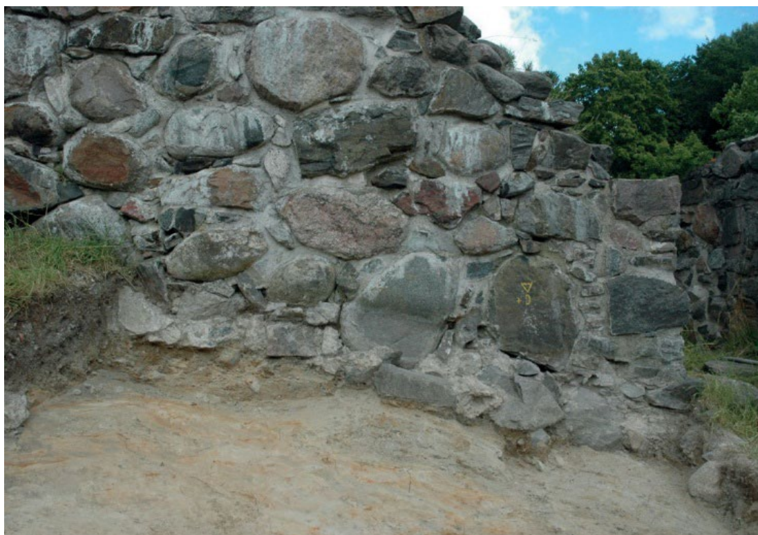
Kuva 11. Kaakkoisen ja eteläisen esilinnan välisen muurin perustus kaivettuna esiin. Kuva: Maija Holappa 2020. Kuvan käyttö kuvaajan luvalla.
