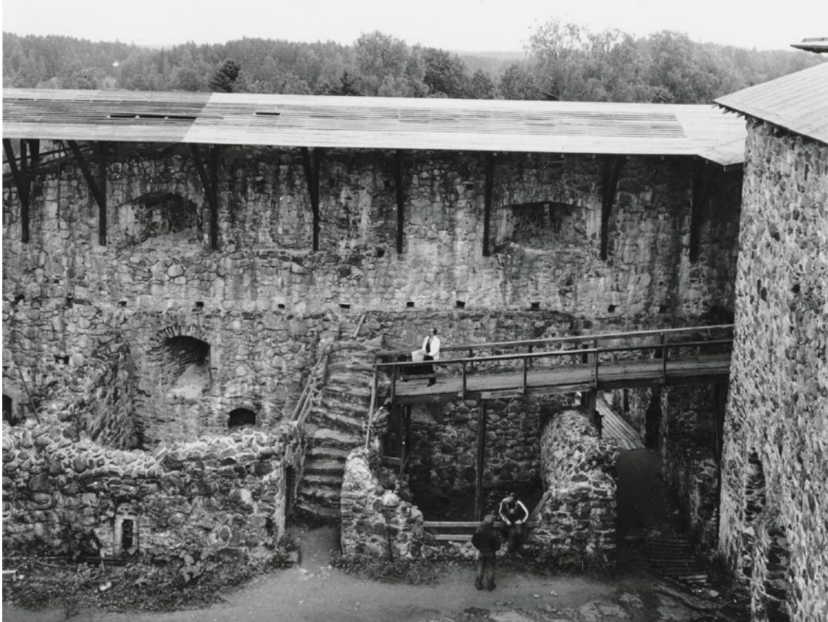
Raaseporin linnanraunioiden suojaus katoksin meneillään. Kuvassa keskellä arkkitehti Erkki Mäkiö. Museovirasto, Rakennushistorian kuvakokoelma, RHO20814:1, RHO20814. Finna.fi.
