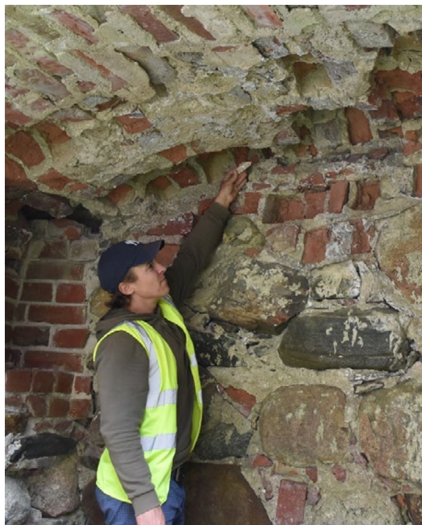
Laastinäyte RA2 otettiin vahtituvan 119 holvatus- ta ja vaurioituneesta osasta. Kuva: Sanna Ihatsu.
