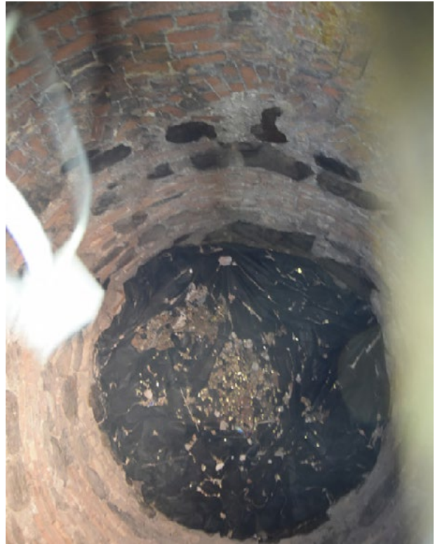
Tornin varastokellarin seinät on tarkasteltu sen yläpuolisen ritilälattian kautta. Kuva: Sanna Ihatsu.
