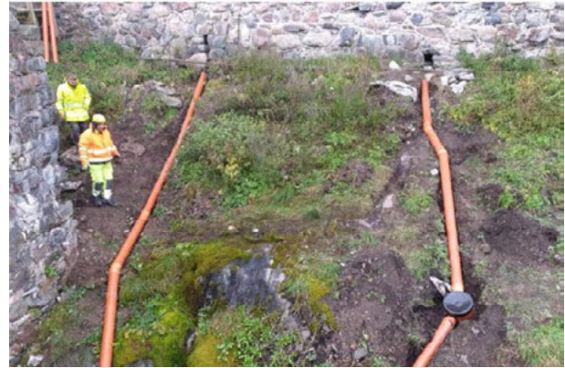
Kuvia katteen kunnostuksesta ja sadevedenohjauksesta Metsähallituksen raportista (2020) Palviainen, "Raaseporin rauniolinnan sadevedenohjauksen parantamisen urakan yhteenve-to". Kuva: Metsähallitus.
