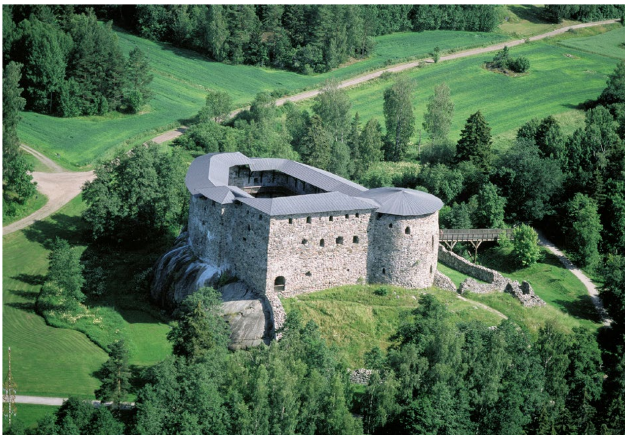
Vallaksen ilmakuvassa vuodelta 1998, MV näkyy 1980-luvun restauroinnin oleellisia periaatteita: Saapuminen linnalle linnaa kiertäen, sisäänkäynti siltaa pitkin pääportista, mahdollisimman eleetön suojakate, puiset kävelytasot päälinnan sisäpihan toisessa kerroksessa.
