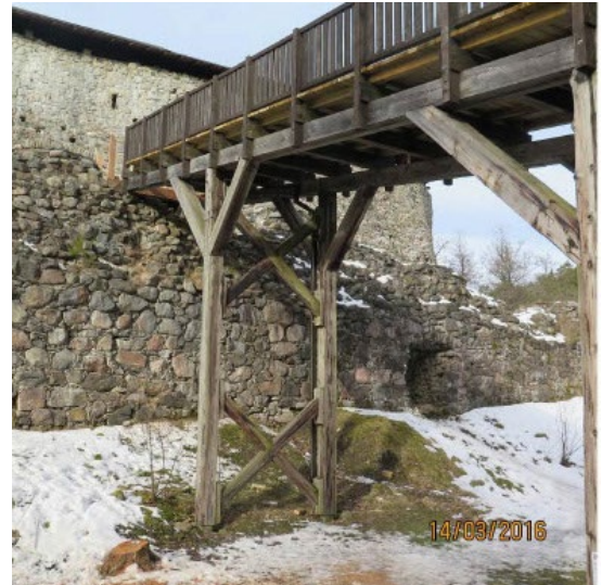
Sillan linnan puoleinen pää uusittiin kokonaan ja linnaan johtavalta osalta uusittiin mm. kansilankut. Valokuvia sillan suunnittelu 2015 ja korjaus 2016. Kuvat: Metsähallitus.
